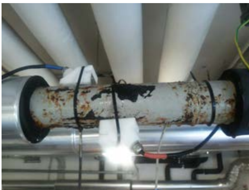
Figura 94: Particolare dell'installazione dei due sensori di portata a ultrasuoni cmap -on
