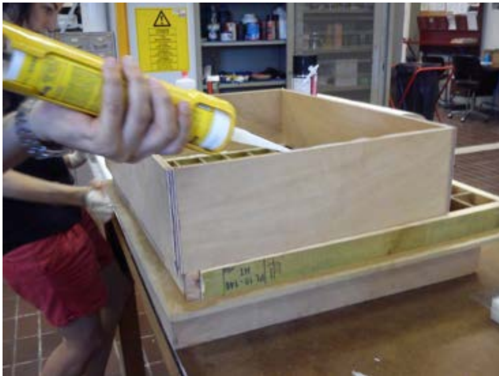
Figura 2.2.4: Applicazione sigillante per la chiusura del pannello.
