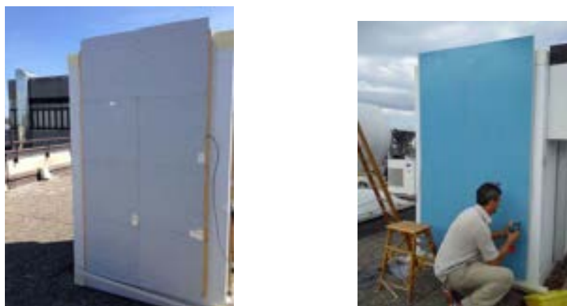
Figura 66. Prime fasi del montaggio dei contenitori di PCM
