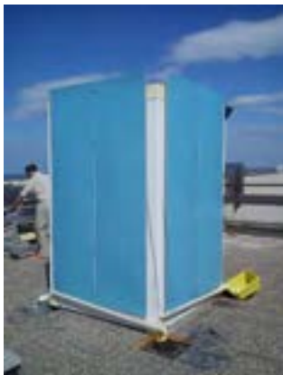
Figura 67. Chiusura con il lamierino di finitura esterna delle pareti della cella frigo di prova
