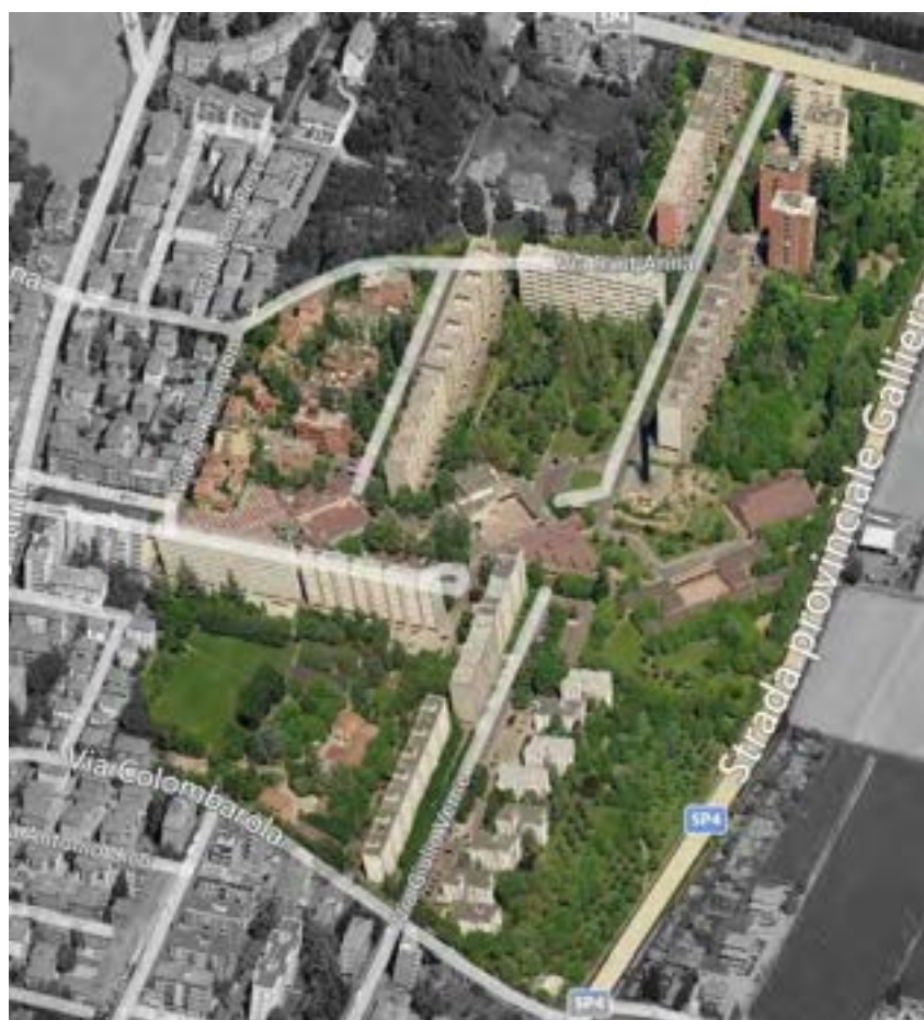
Figura 29 - Quartiere servito dalla rete di teleriscaldamento - vista aerea
