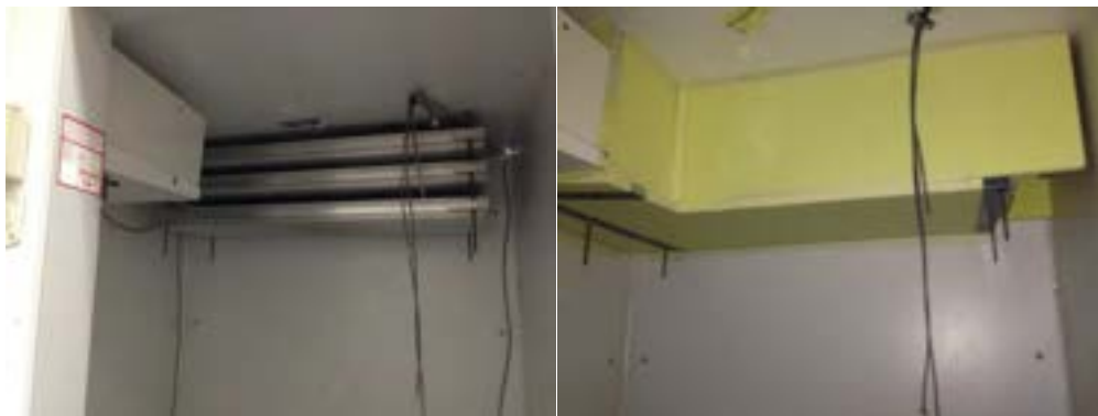
Figura 13. Fotografia dello scambiatore di PCM: (a) prima dell'applicazione del canale (b) con il canale per l'aria esterno.
