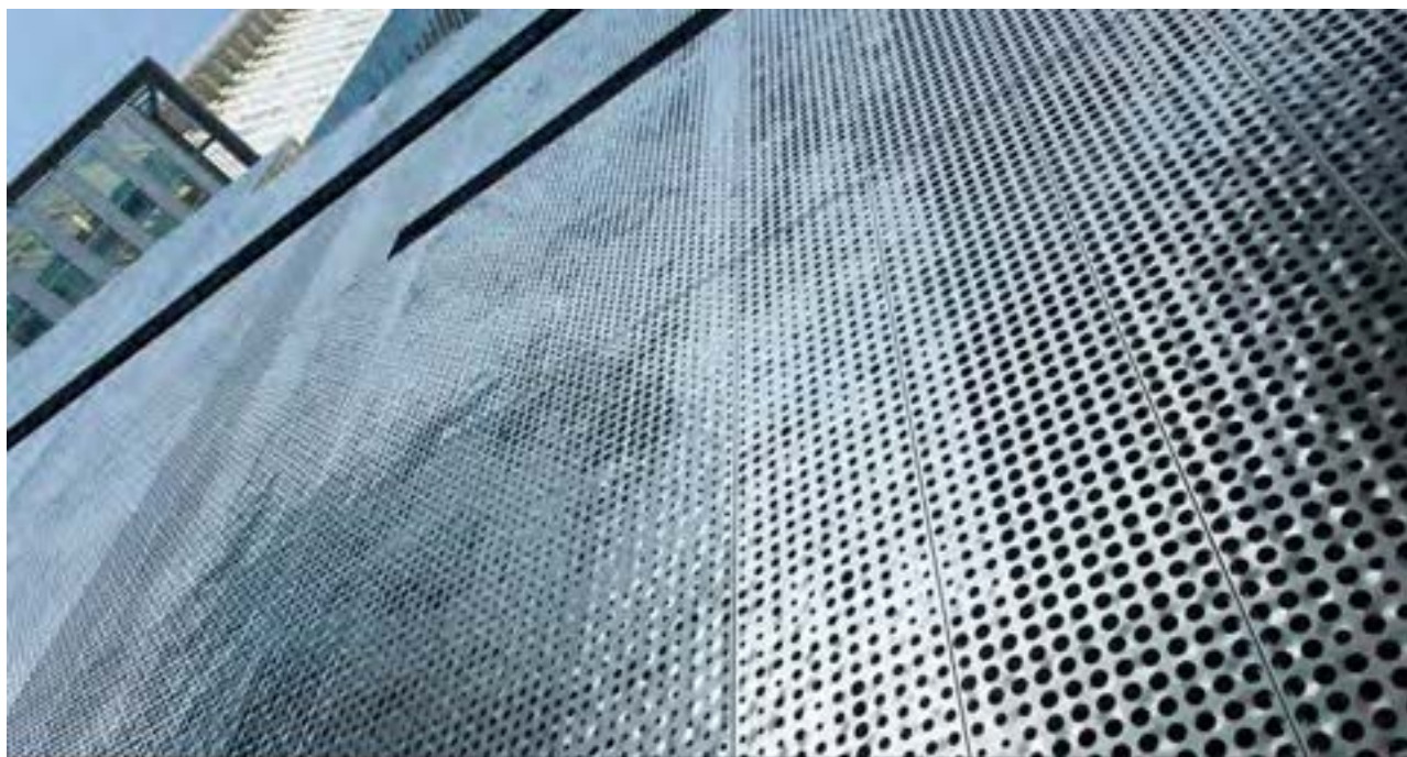
Fig. 4 – Seconda pelle come sistema di controllo solare costituita da lamiera microforata riflettente con fori a geometria variabile. FAIRMONT PACIFIC RIM (fonte: http://www.archiexpo.com )
