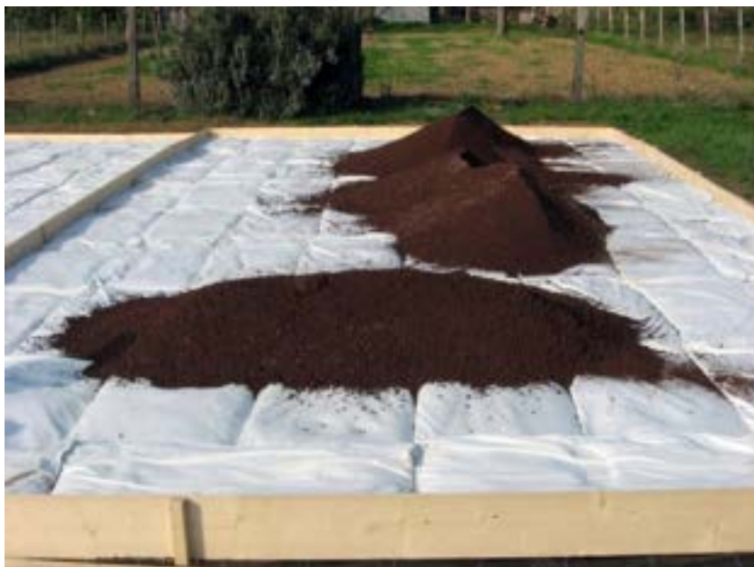
Strato di cuscini di idroperlite in fase di ricoprimento del substrato costituito dalla miscela di zeolite, pomice e lapillo.
