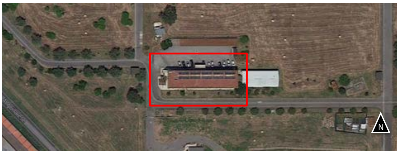
Figura 7. Edificio F51 del Centro Ricerche Casaccia dell’ENEA – fonte Google Maps
