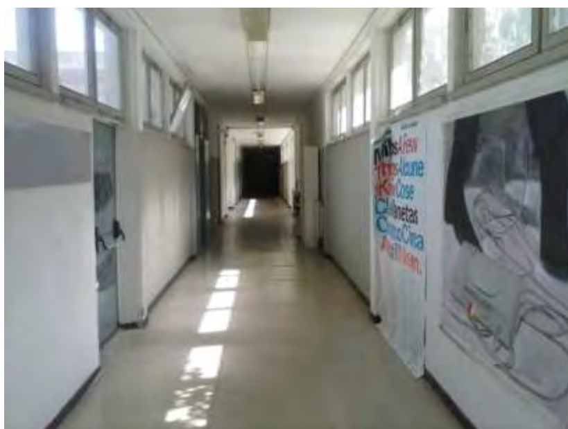
Figura 6 Interno blocco 4 con funzione di connettivo
