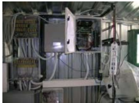
Figura 2.2.7: Stazione meteorologica presso il campo sperimentale dell'Università di Bari: interno della stazione meteo (sinistra) e data logger (destra).
