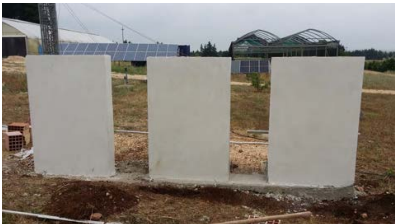
Figura 2.2.2: Le tre pareti verticali in scala realizzati presso il campo sperimentale dell'Università di Bari (Giugno 2014).
