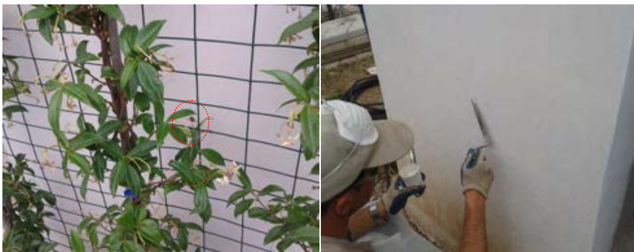
Figura 2.2.9: Sensore della temperatura dell'intonaco esterno: sensore appena inserito (sinistra, nel cerchio); sensore ricoperto da uno strato sottile di intonaco (destra).
