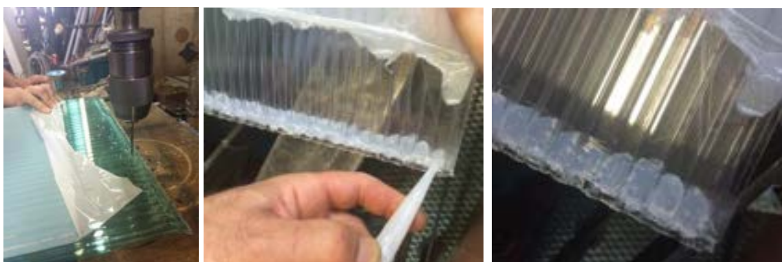
Figura 9 Sigillatura con silicone inserito attraverso un foro praticato sul fondo degli alveoli di un pannello in policarbonato
