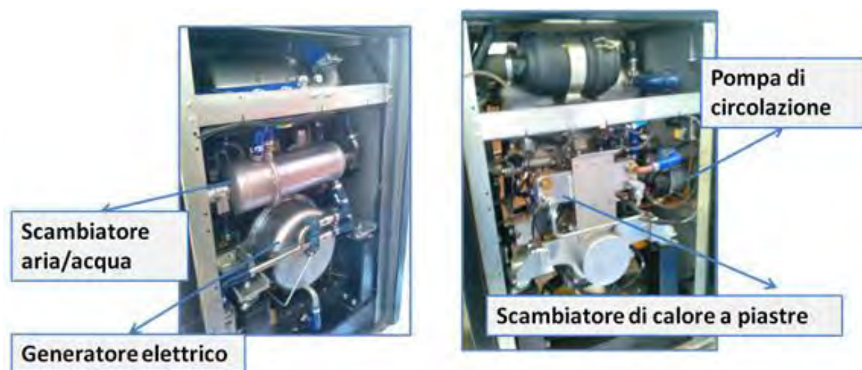
Figura 45. Vista interna cogeneratore
