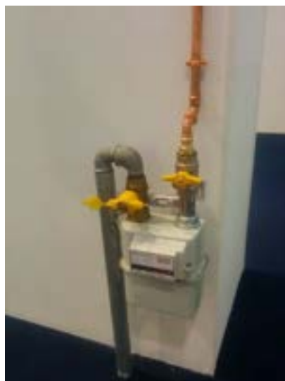
Figura 3. Particolare valvola di regolazione gas
