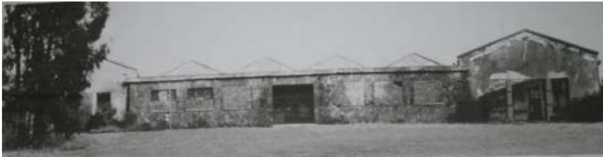
Foto 6.1. Facciata principale dell'ex Magazzino materiali prima dell'intervento di ripristino
