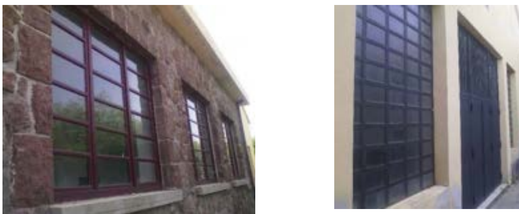
Foto 6.4. Superfici vetrate e portone
