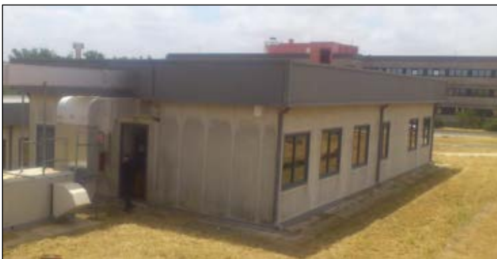
Figura 2.1.1 - L'edificio container F76. Sopralluogo Unisannio del 24 Giugno 2013
