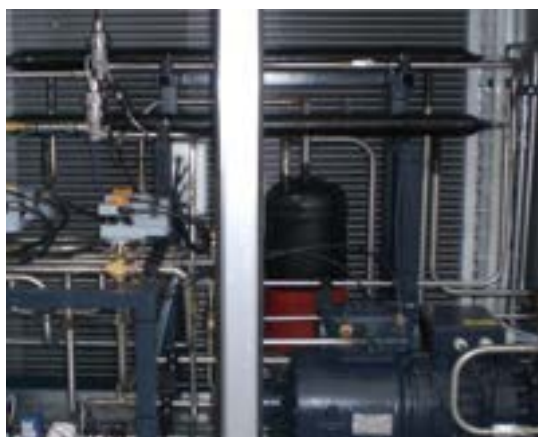
Figura 45 Ricevitore di liquido.
