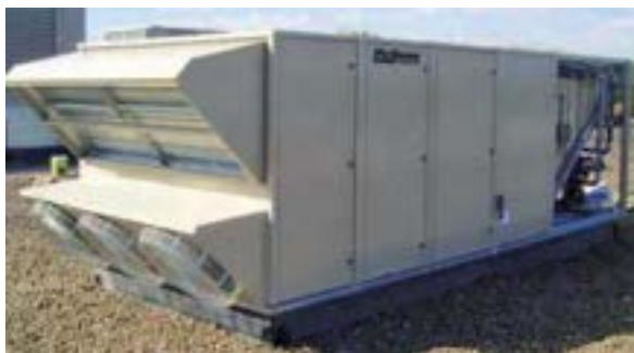
Figura 18 Modello Maverik I di Mc Quay capacità da 10 kW a 150 KW ad R-410A.
