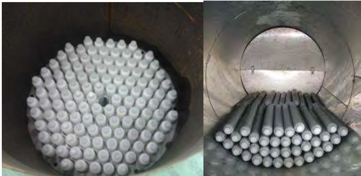
Figura 3 - Tubi contenenti PCM S46, nel serbatoio di accumulo
