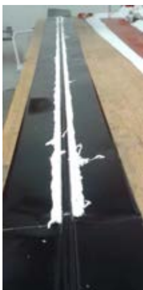
Figura 5.13 – Applicazione della pasta conduttiva.
