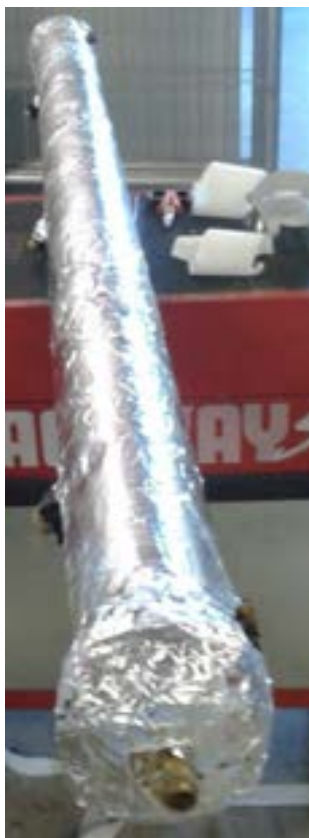
Figura 5.16 – Isolamento del serbatoio.
