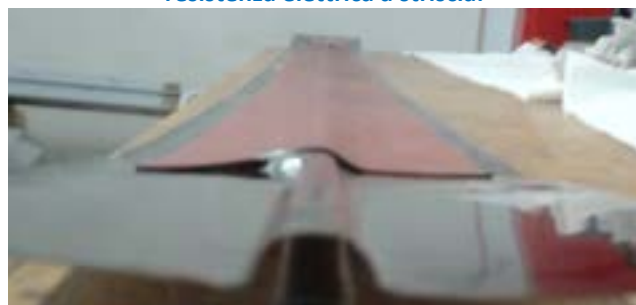
Figura 5.15 – Incollaggio della resistenza elettrica a striscia dopo l'applicazione della pasta conduttiva.
