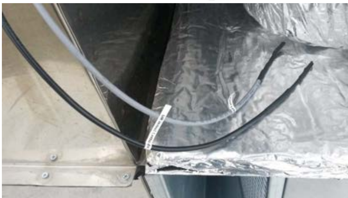
Figura 23 .Sensori di umidità (nero) e di temperatura (grigio)
