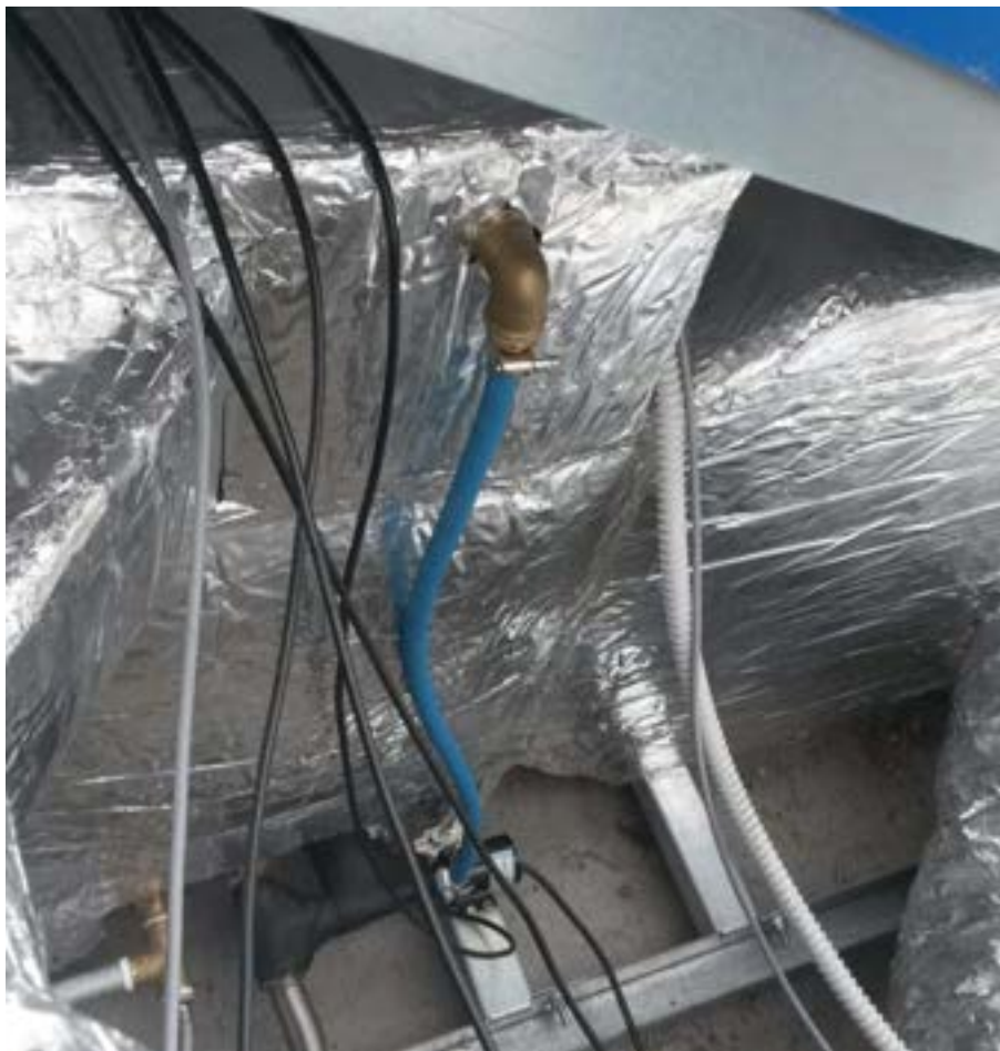
Figura 18 . Pompa di circolazione dell'acqua
