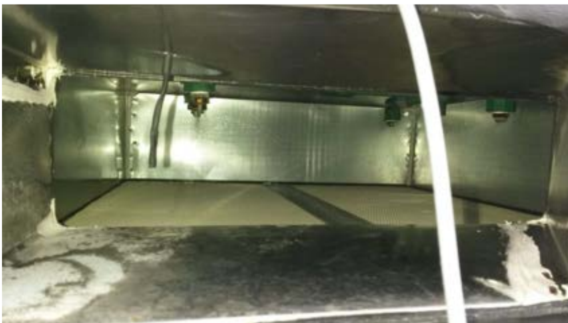
Figura 16b. Parte alta degli scambiatori di calore con ugelli nebulizzanti azionati
