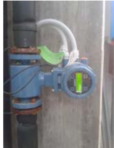
Figura 22. Misuratori di portata installati lato acqua, Krohne optiflux 5000 a sinistra e Rosemount 8732E a destra
