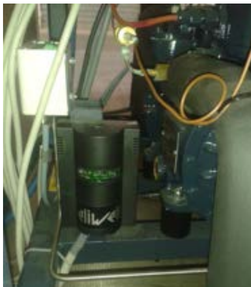
Figura 30. Sensori Eliwell a bordo quadro elettrico e lato compressore
