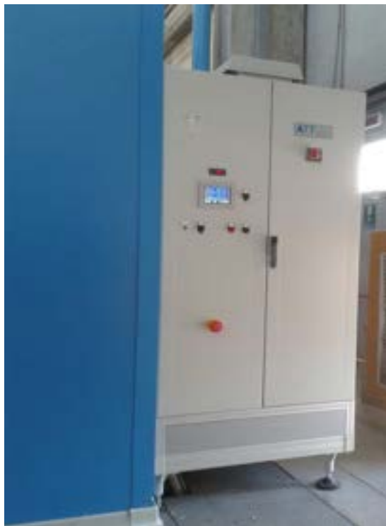
Figura 4. Quadro elettrico con pannello di controllo Touch Screen della camera climatica e sensori di temperatura e umidità alloggiati all'interno della stessa
