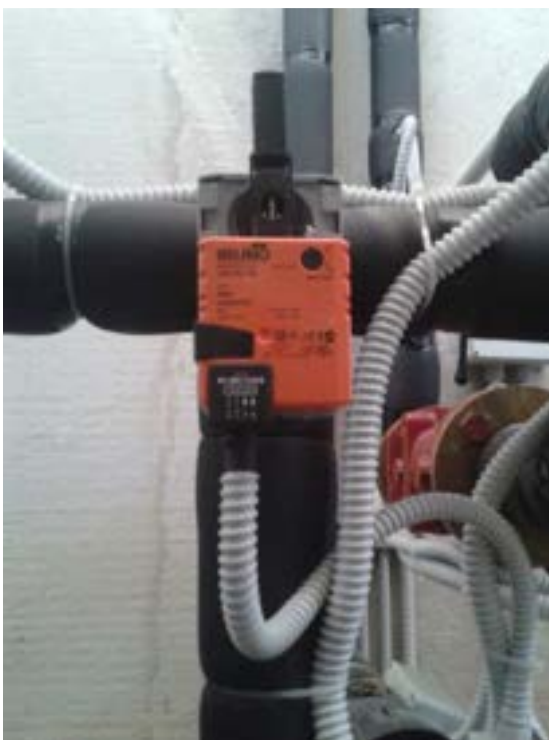
Figura 11. Valvola miscelatrice a tre vie
