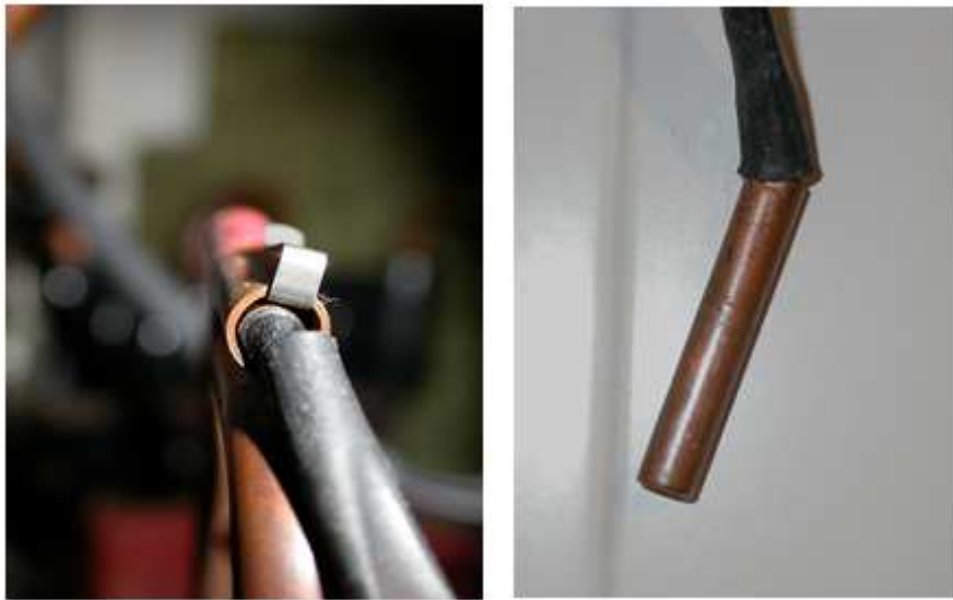
Figura 32. Sonda di temperatura uscita compressore.
