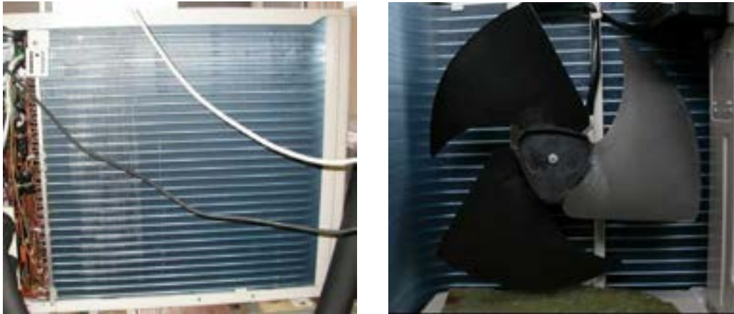
Figura 19. Scambiatore ad aria (evaporatore).
