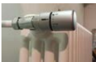
Figura 25. Valvole e testa termostatiche tradizionali del tipo on/off.
