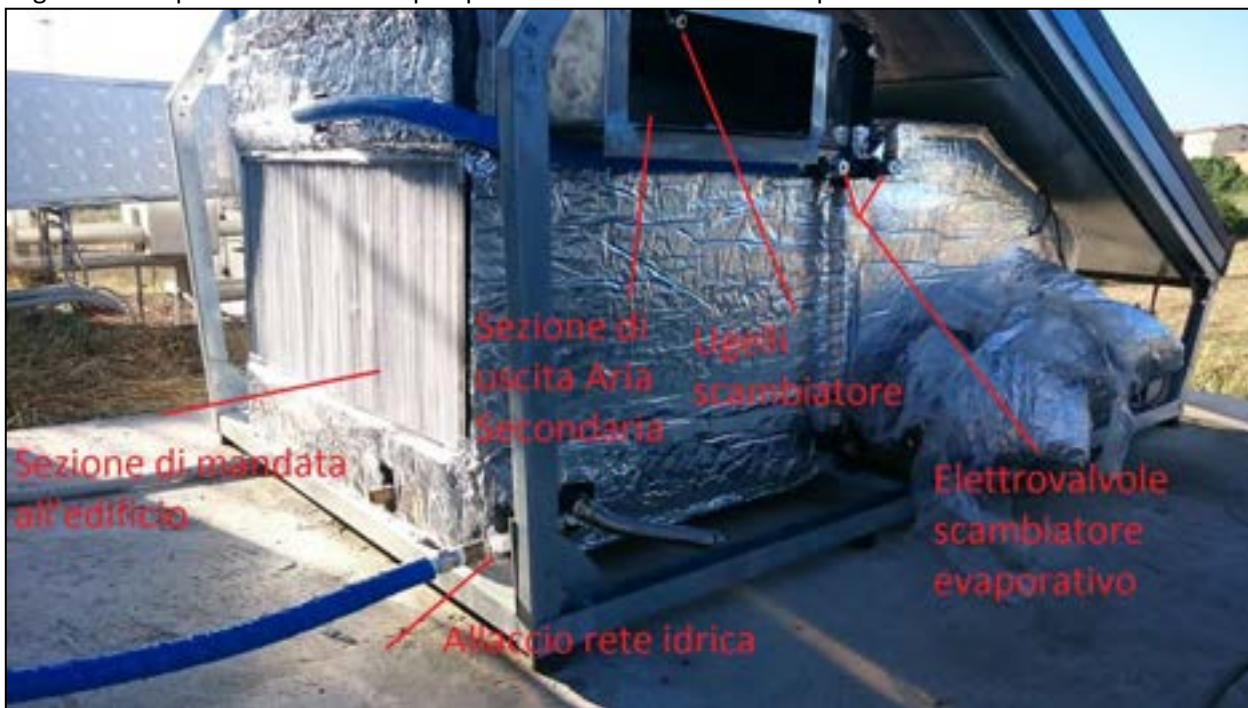
2.4 Scambiatore evaporativo a pacco
