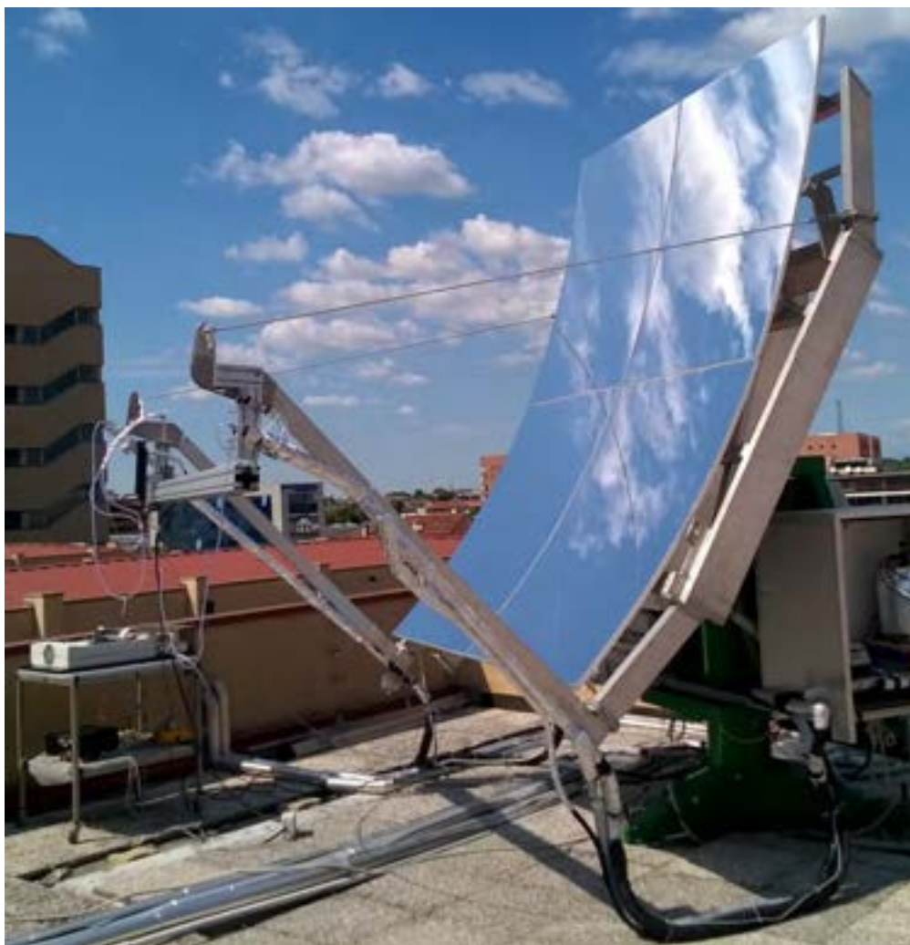
Figura 26 – Concentratore sperimentale sul tetto del Dipartimento di Ingegneria Industriale dell'Università degli Studi di Padova.
