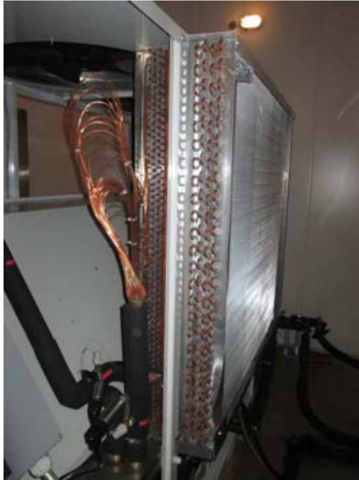
Figura 22. Batterie alettate
