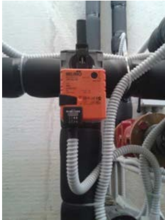
Figura 1. Valvola miscelatrice a tre vie
