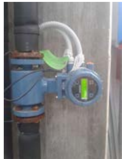
Figura 27. Misuratori di portata installati lato acqua, Krohne optiflux 5000 a sinistra e Rosemount 8732E a destra
