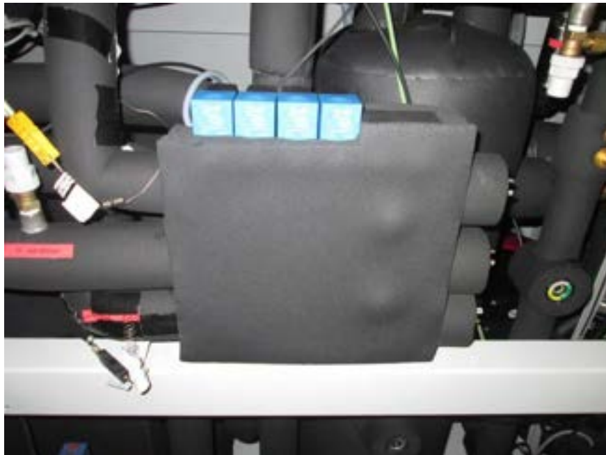
Figura 23. Particolare del pacco eiettori
