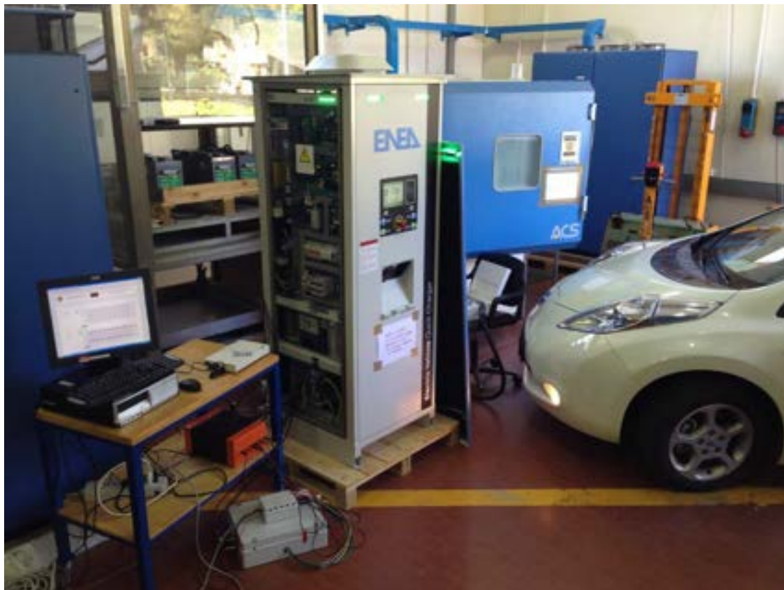
Fig. 79 –Il sistema automatico di collaudo e di test, il sistema di conversione e l'autoveicolo durante le prove
