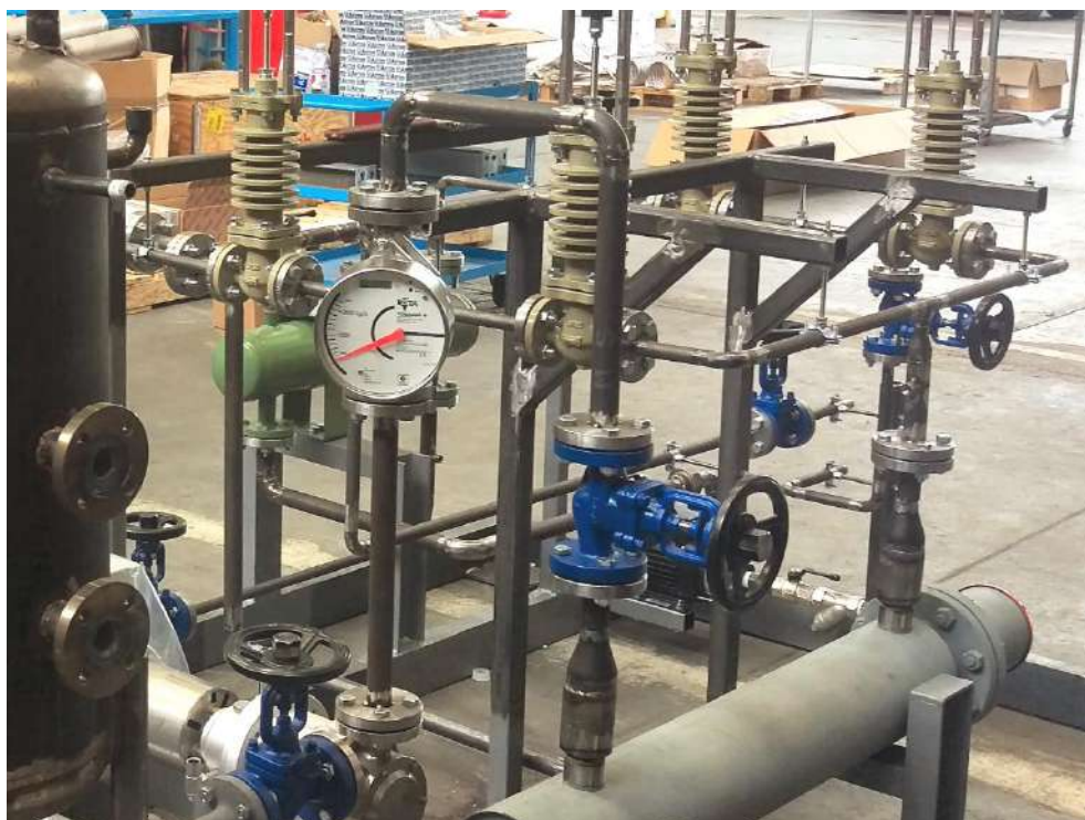
Figura 4: Impianto SOLTECA-3 durante la realizzazione
