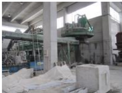
Figura 7- Impianto per il confezionamento del calcestruzzo.
