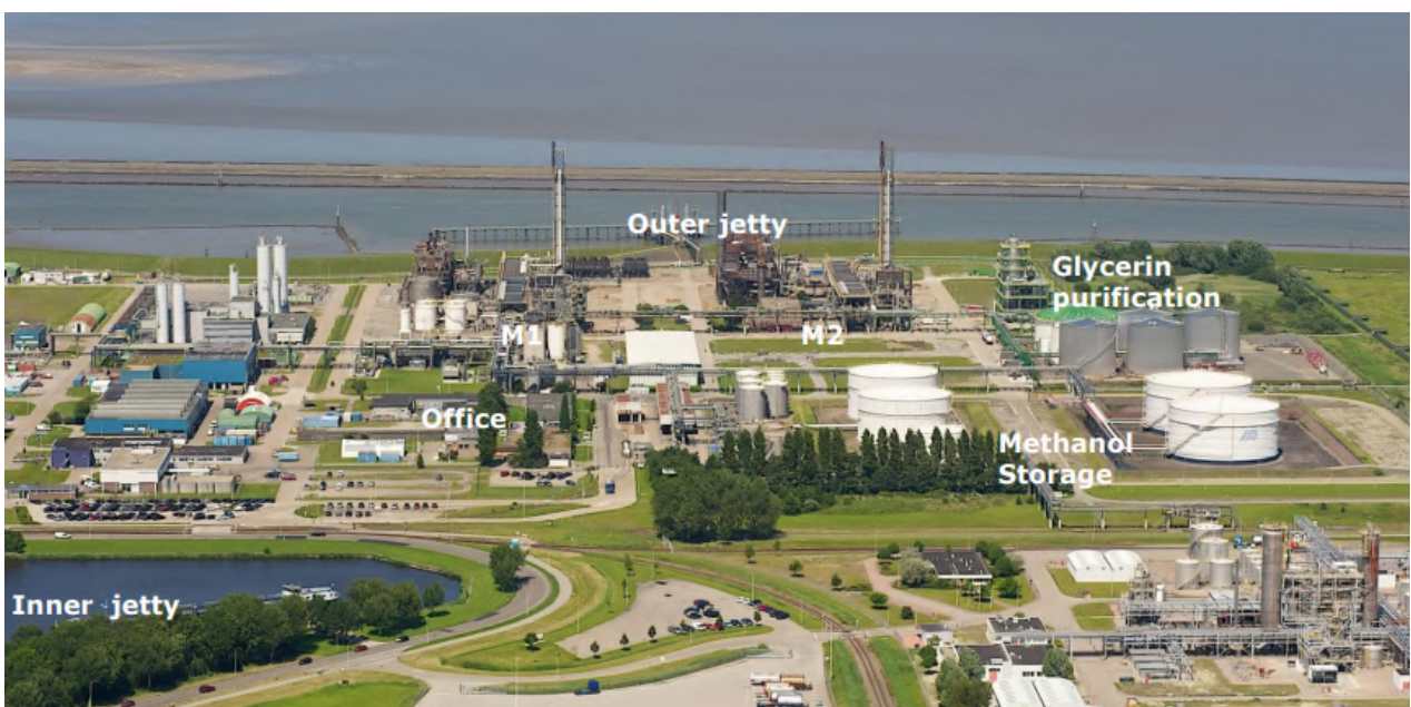
Figura 38. Impianto BioMCN in Delfzijl, Paesi Bassi [178].
