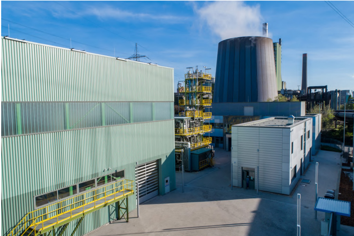
Figura 36. Il sito Carbon2Chem, situato proprio nei locali dell'enorme sede siderurgica Duisburg di Thyssenkrupp [175].
