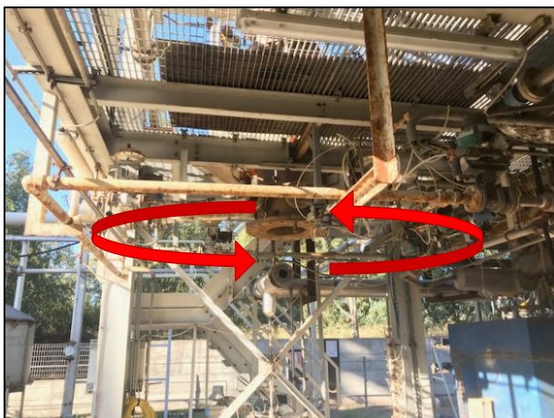
Figura 4.17 – Anello di alimentazione aria lampade.
