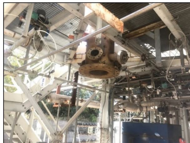
Figura 4.20 – Piano terra, a seguito della rimozione dell'anello.
