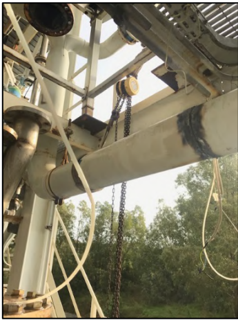
Figura 4.73 - Taglio tubazioni di aspirazione secondo piano.
