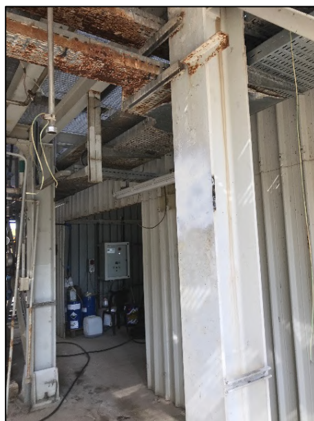
Figura 4.35 – Trave a seguito della rimozione della mensola.
