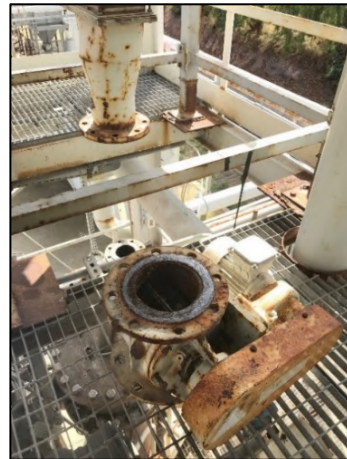
Figura 4.54- Rotocella disinstallata.
