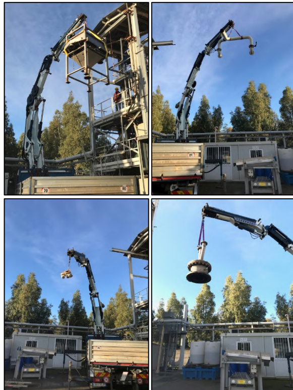
Figura 4.76 – Rimozione di tramoggia, tubi aspirazione, rotocella e testa del reattore.
