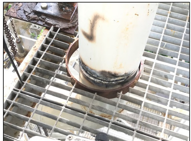
Figura 4.72 - Taglio tubazioni di aspirazione primo piano.
