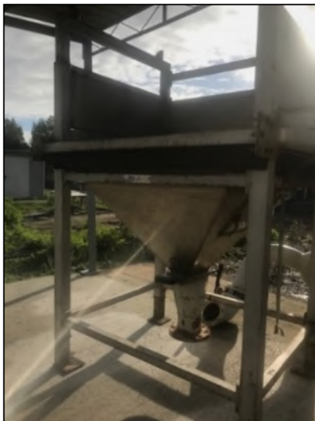
Figura 4.77 - Tramoggia di caricamento dopo la rimozione.
