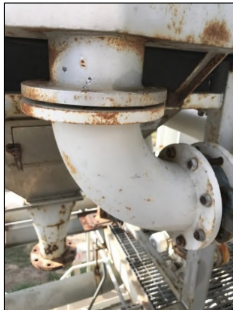
Figura 4.55 – Rimozione bulloni dai tubi di aspirazione polveri.
