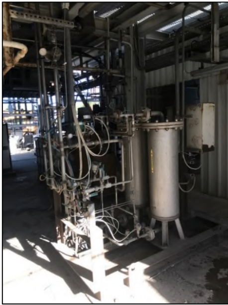
Figura 4.43 – PSA prima della rimozione
