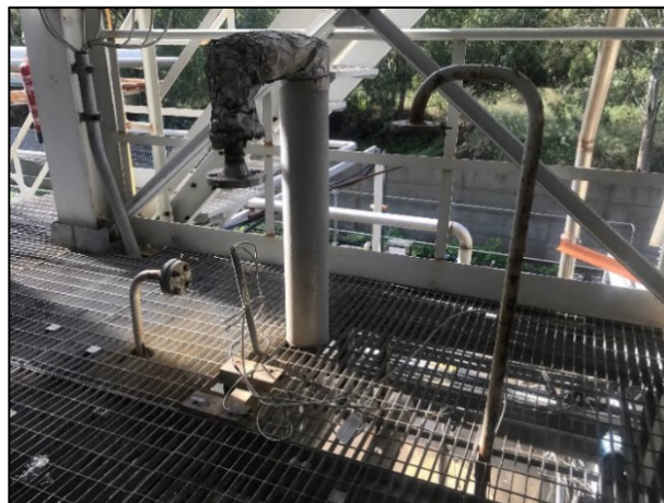
Figura 4.57 - Area dopo lo smontaggio del BA003.
