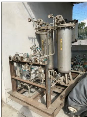
Figura 4.47 - PSA a seguito della disinstallazione.
