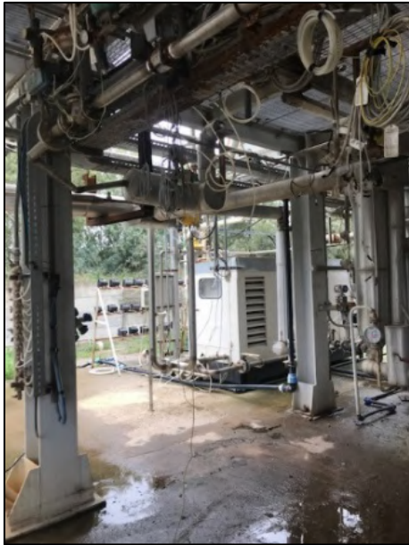
Figura 4.65 - Piano terra dopo la rimozione del riscaldatore.
