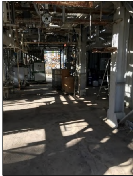
Figura 4.44 – Piano terra del castelletto a seguito della rimozione del PSA.
