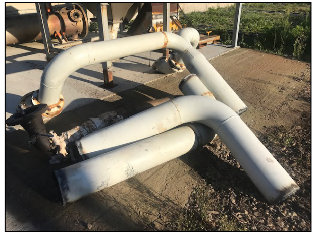
Figura 4.74 - Tubazioni dell'aspirazione polveri rimosse.
