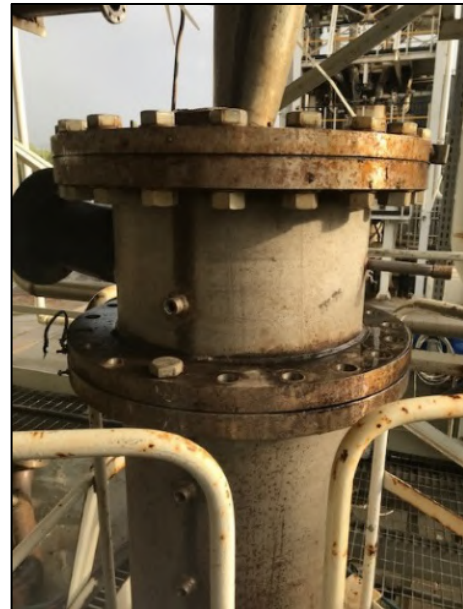
Figura 4.70 - Smontaggio parziale dei bulloni della testa del reattore.
