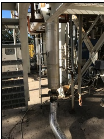
Figura 4.41 – Tubo di alimentazione agenti gassificanti ricollegata.
