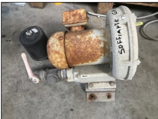
Figura 4.67 – Soffiante del gasometro dopo la rimozione.
