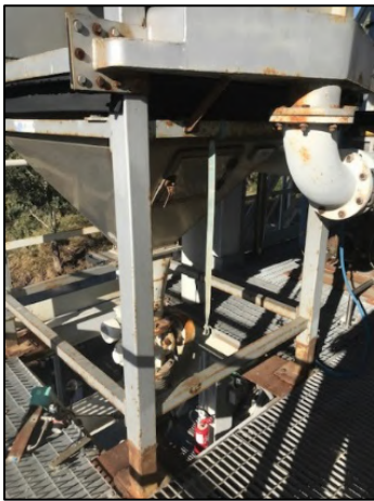
Figura 4.49 - Tramoggia a seguito della rimozione della valvola a ghigliottina.
