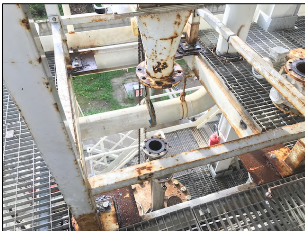
Figura 4.71 - Sostituzione bulloni bloccati da supporti tramoggia.
