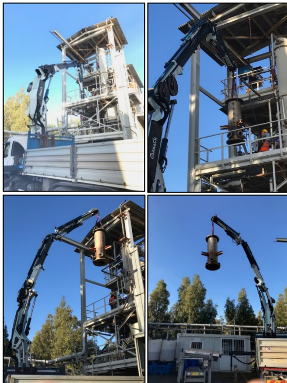
Figura 4.79 - Fasi di rimozione del reattore di gassificazione.
