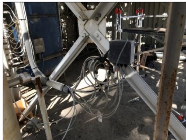
Figura 4.33 – Area a seguito della rimozione delle linee O 2 e CO 2 .
