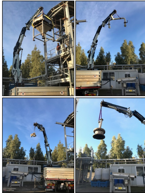
Figura 8. Rimozione di tramoggia, tubi aspirazione, rotocella e testa del reattore
