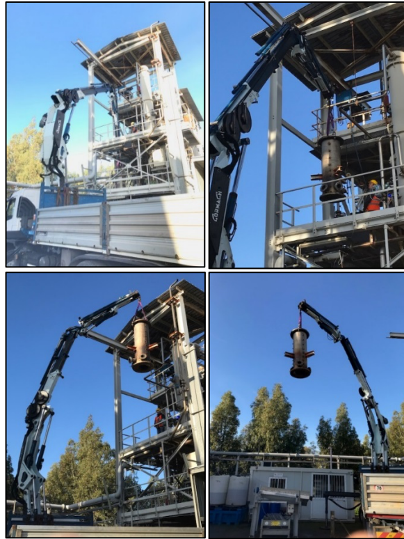
Figura 7- Fasi di rimozione del reattore di gassificazione
