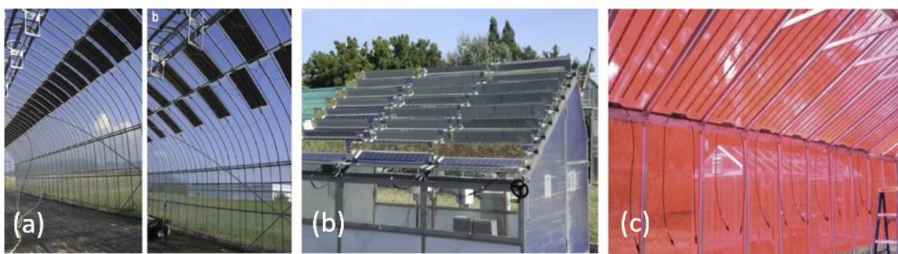
Figura 2.1.1: Soluzioni per l'impiego del fotovoltaico nelle serre basate sullo stato dell'arte: (a) fisse con diversi pattern, (b) dinamiche, (c) fotovoltaico innovativo.
