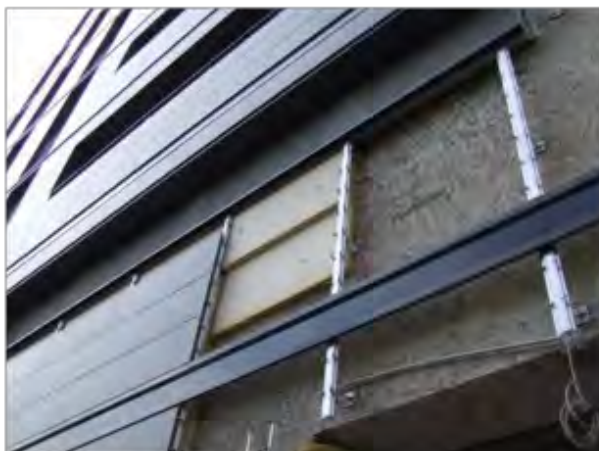
Particolare della facciata Est, vista della facciata ventilata in costruzione, montata con sistema Dallera Tecnologie, modello "Venere Nascosto"
