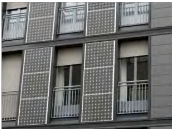
Particolare della facciata Sud, vista dei moduli fotovoltaici
