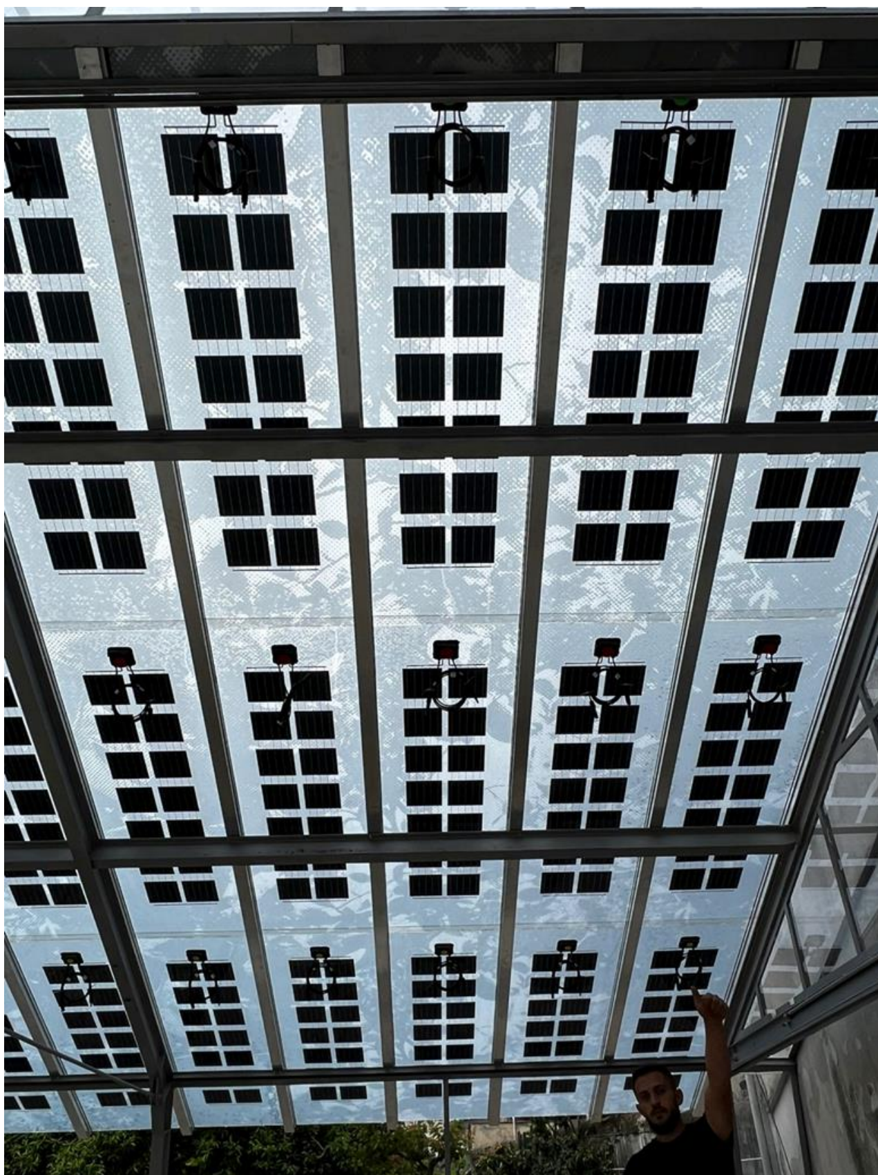
Figura 2.2.9. La falda realizzata vista dall'interno.
