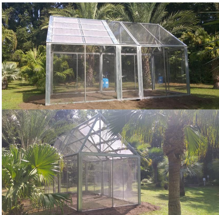
Figura 40 Realizzazione della serra media con copertura di pannelli di policarbonato trasparente.
