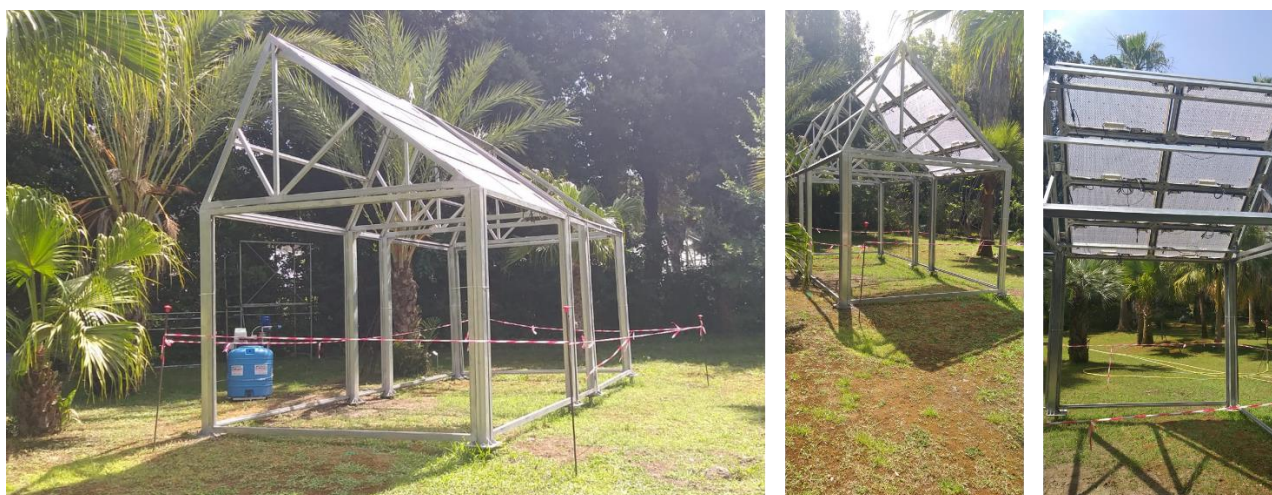
Figura 39 Posa in opera della struttura portante della serra media e dettaglio dei moduli BIPV.
