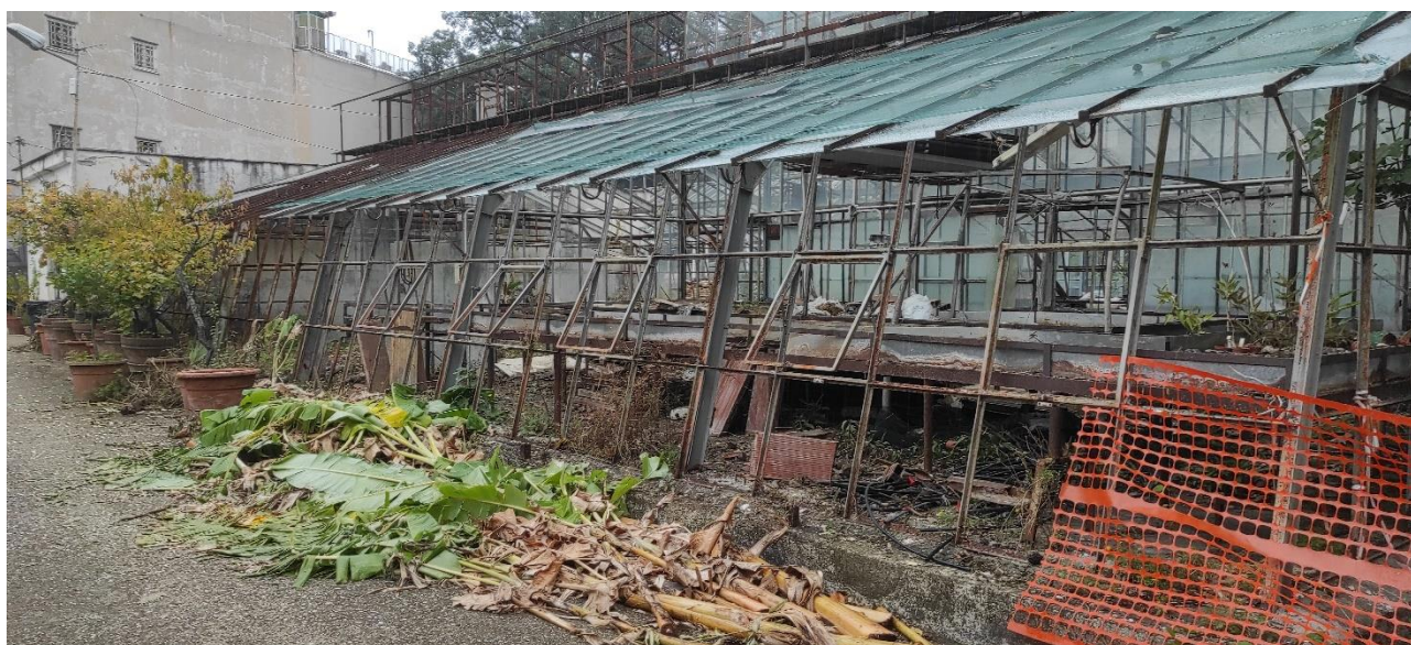
Figura 3 Rimozione della vegetazione nella serra storica. Dato il disuso e l’impraticabilità non è stato possibile negli anni precedenti all’intervento di poter intervenire con opere di pulizia periodica
