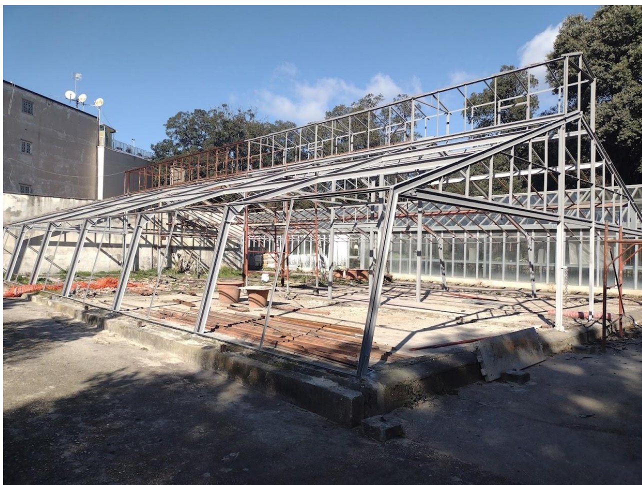
Figura 6 Serra storica durante l'opera di sostituzione delle strutture in ferro erose dal tempo e la fase di sabbiatura della struttura rimanente
