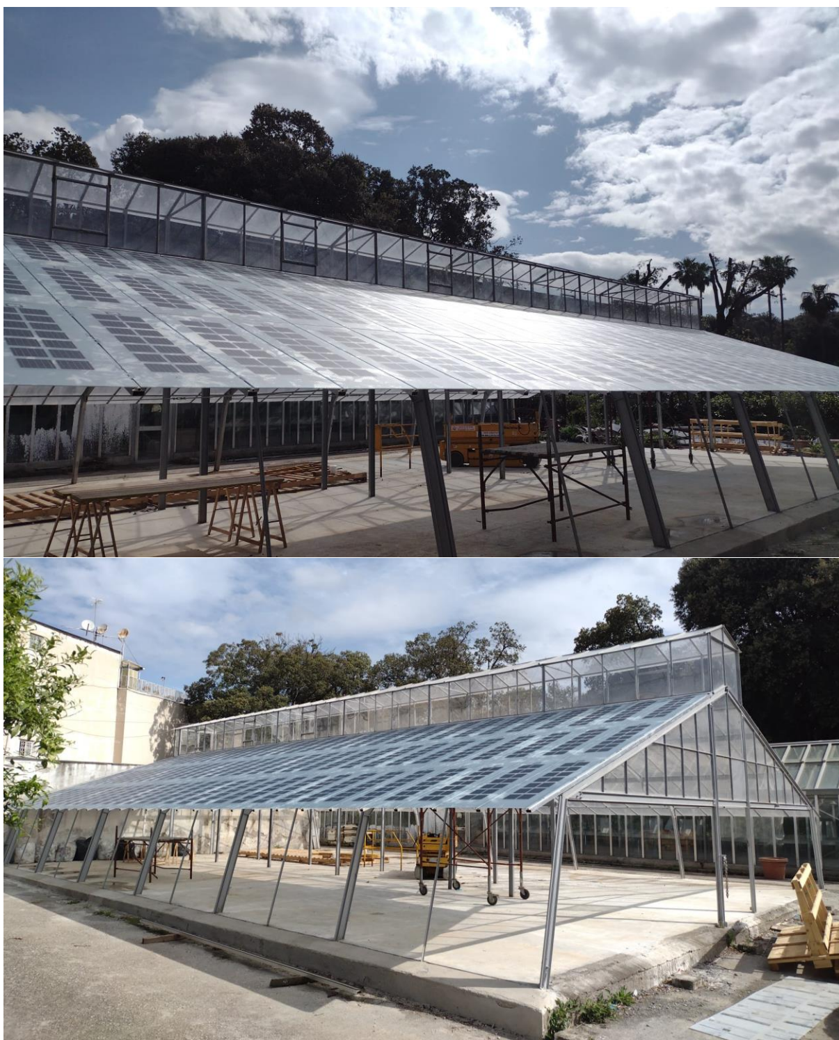
Figura 13 Veduta della falda sud dopo installazione dei pannelli BIPV da diverse angolazioni
