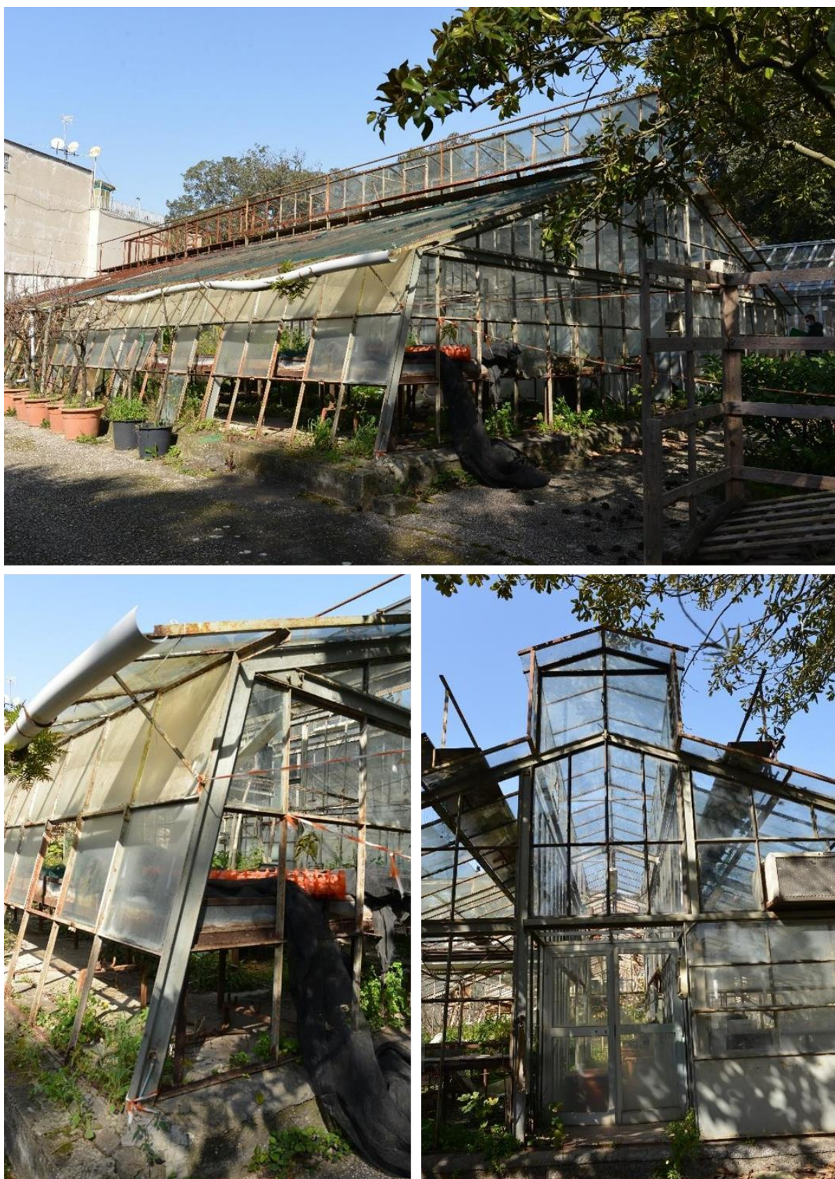
Figura 1 Dettaglio della serra di “ex-Patologia” individuata per la ristrutturazione. In alto la vista laterale sul lato est della struttura. In basso a sinistra, l’angolo esposto a sud-est. In basso a destra la vista frontale della struttura.
