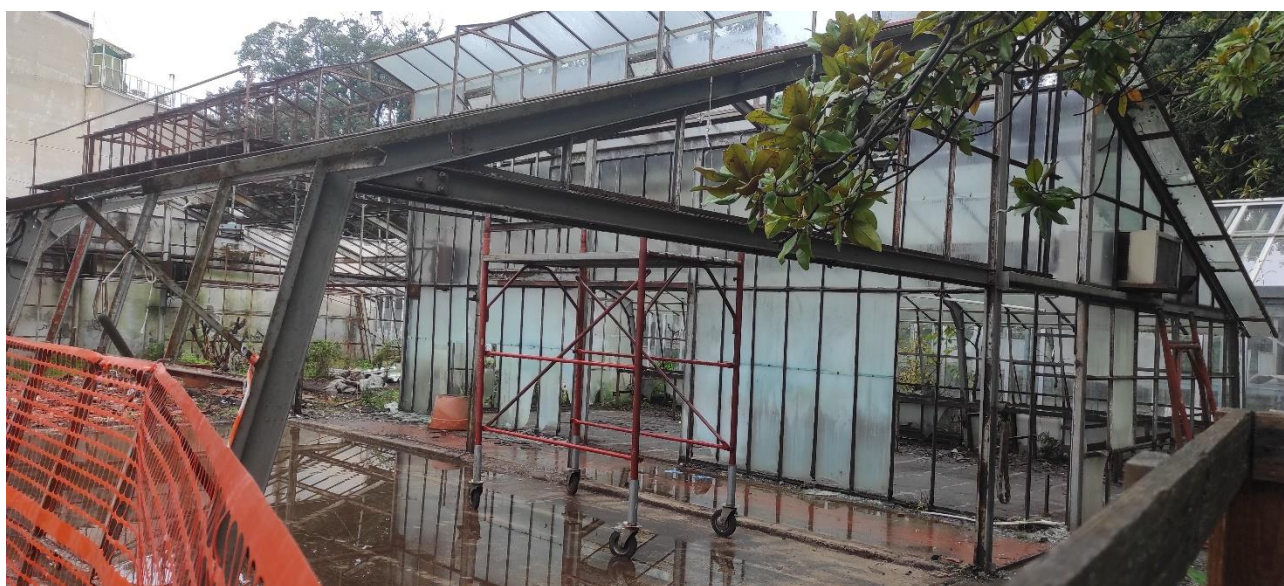
Figura 5 Rimozione delle coperture vetrate sulla serra storica. Vetrate che verranno sostituite con pannelli BIPV e pannelli in polycarbonato trasparente.
