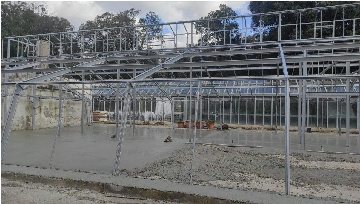
Figura 7 Serra storica durante la messa in posa del massetto
