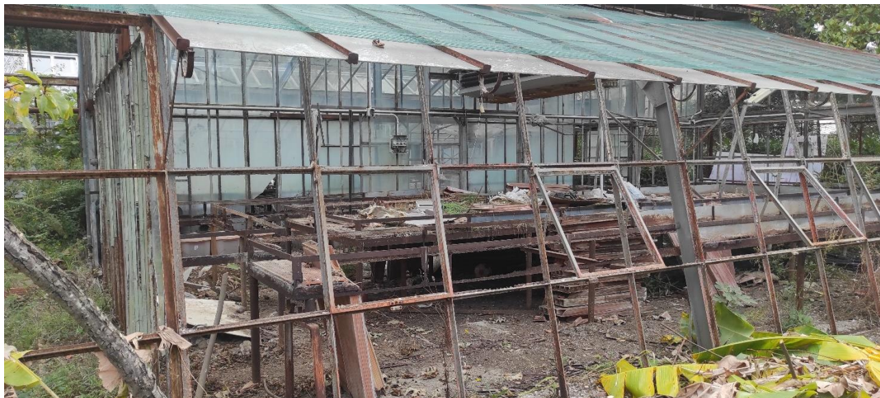
Figura 4 Operazioni di pulizia dell’allestimento interno alla serra storica. Si notano i bancali con scheletro in ferro ed i ripiani in mattoni forati che venivano utilizzati per eseguire le prove sperimentali di patologia.
