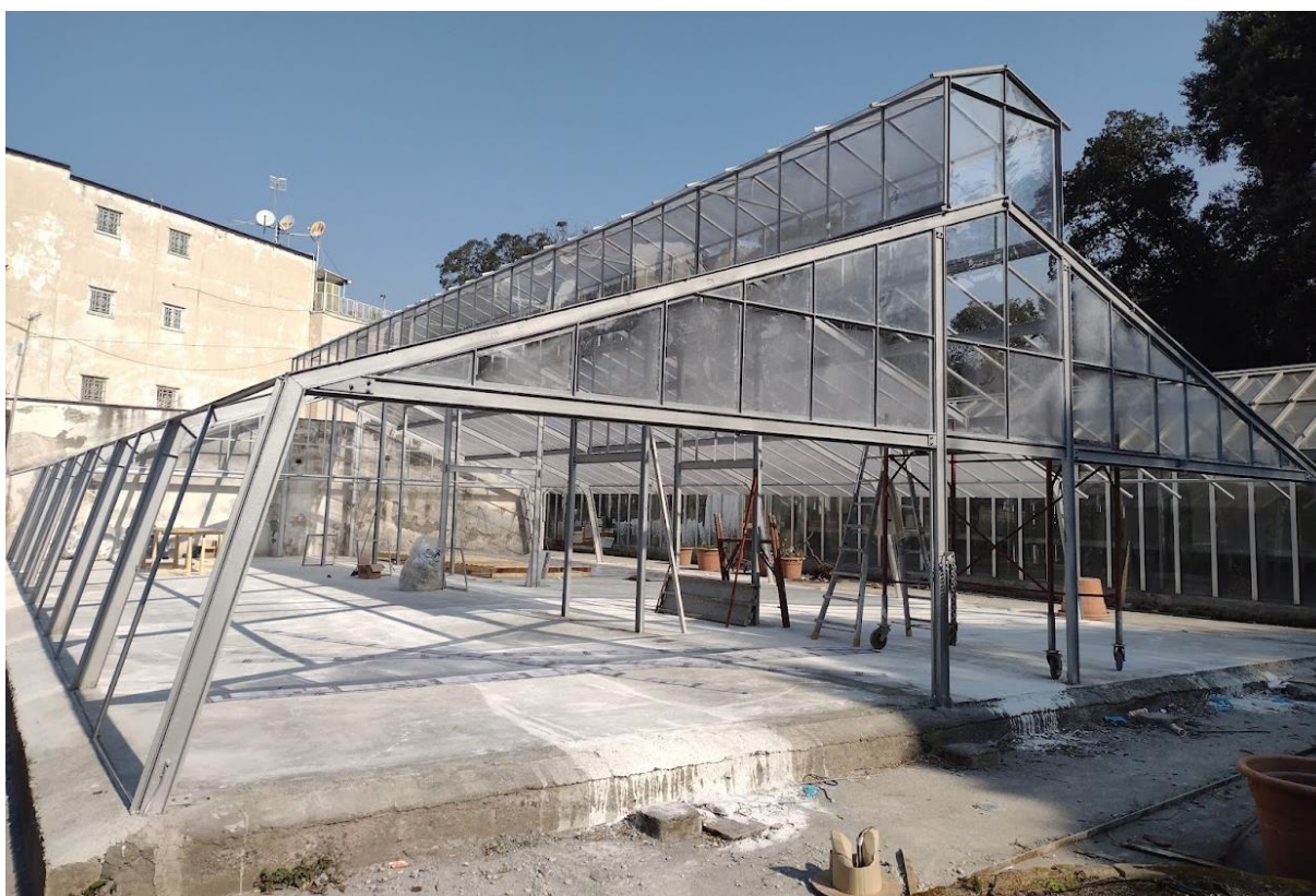
Figura 9 Serra storica dopo la messa in opera delle coperture in policarbonato trasparente e prima dell'applicazione dei pannelli BIPV
