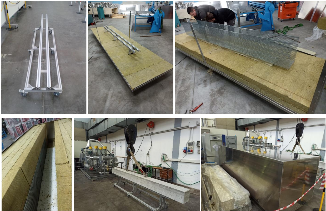
Figura 5-3 Sequenza fotografica relativa alla realizzazione e messa in opera del sistema di coibentazione riutilizzabile per gli elementi di accumulo termico SH02. (a) carrello di supporto; (b) coibentazione di base; (c) alloggio per elemento; (d) coibentazione laterale; (e) movimentazione elemento per alloggiamento; (f) Coibentazione completata
