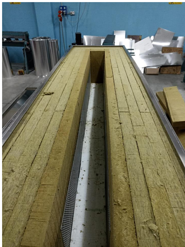
Figura 3-3 -Posizionamento dei materassini di lana di roccia all'interno del sistema di coibentazione del modulo.
