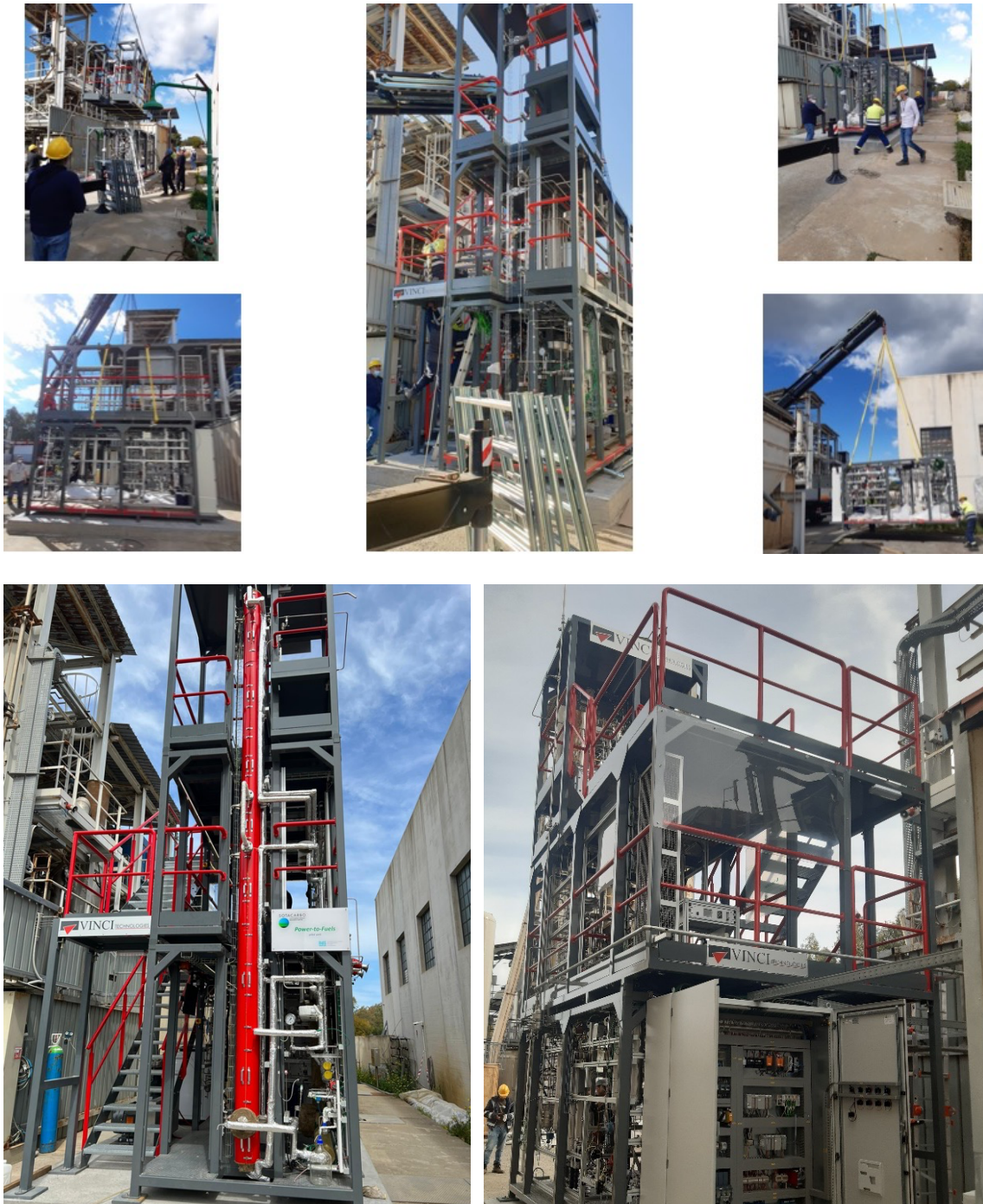
Figura 2.7. Installazione impianto Power-to-Fuels presso la Piattaforma Pilota Sotacarbo.
