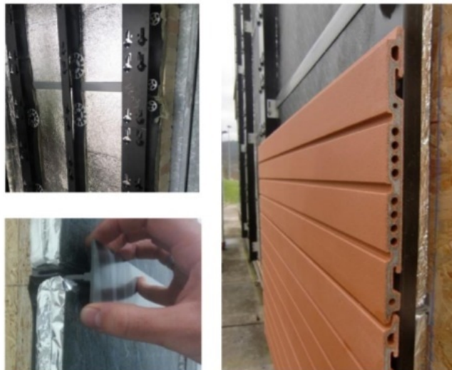
Figura 33. Dettagli sull'installazione del sistema di soluzioni di retrofitting esterno. Montaggio a parete degli elementi di fissaggio meccanico per VIP (a sinistra) e soluzione di facciata generale nel prototipo su piccola scala. Fonte: [95]
