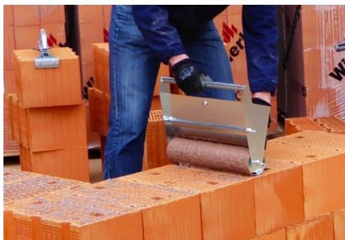
Figura 13. Posa sul blocco rettificato del collante con apposito rullo. Fonte: [63]
