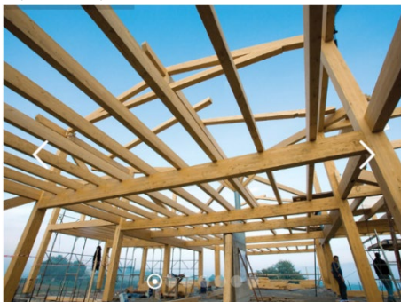
Figura 19. a) Struttura in telaio di legno lamellare; b) Struttura in pannelli di legno lamellare X-Lam. Fonte:[67]
