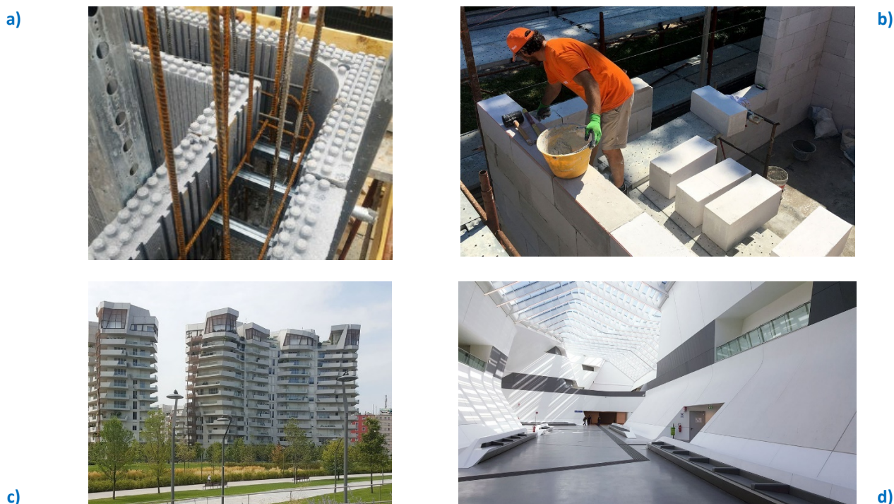
Figura 17. a) sistema a setti in c.a. con casseforme in EPS a rimanere (Fonte: [65]); b) sistema a blocchi di CCAA; c) e d) esempi di realizzazione con l'impiego di blocchi in CCAA (Fonte: [66])
