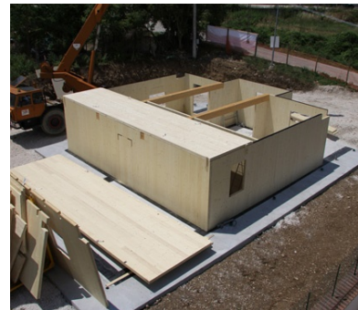
Figura 19. a) Struttura in telaio di legno lamellare; b) Struttura in pannelli di legno lamellare X-Lam. Fonte:[67]
