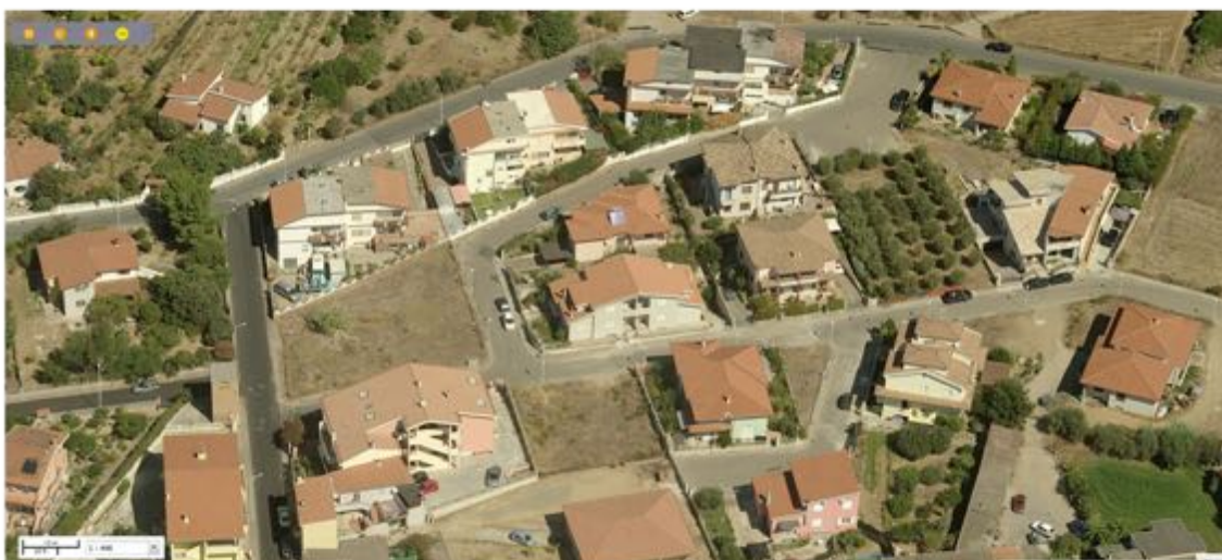
Vista 1-2, zona C1.1
