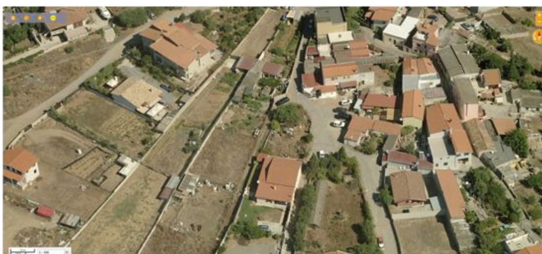
Vista 1-3, edificio zona B2.3
