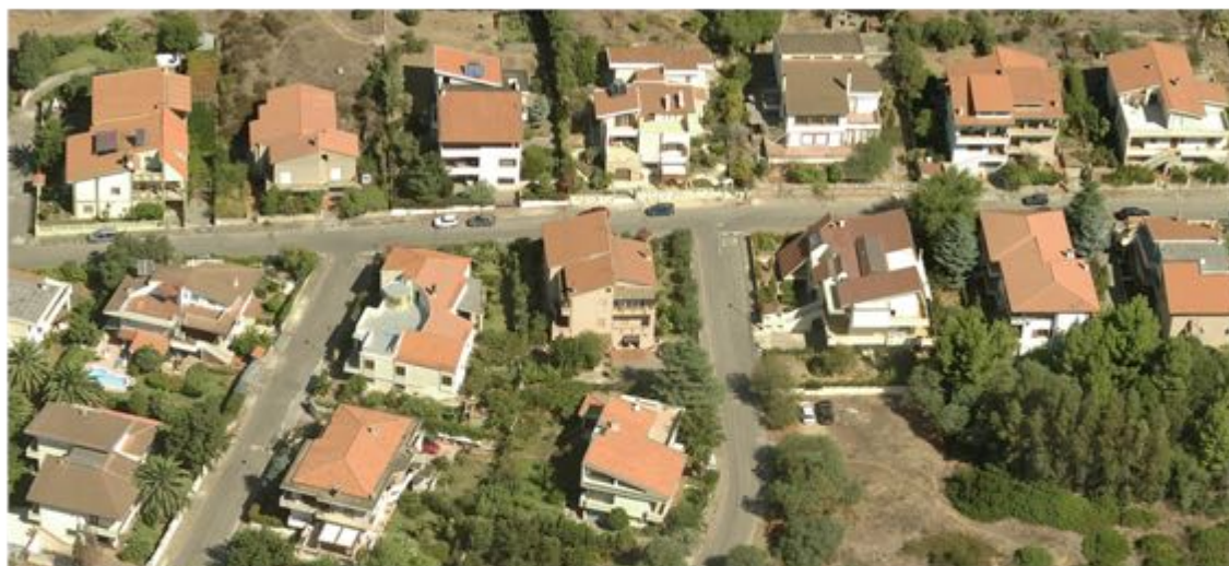
Vista 1-1, edifici isolati, zona B2.1
