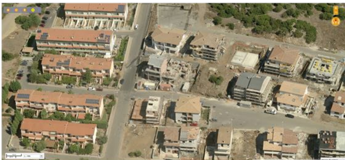
Vista 2-1, edifici in linea, zona C1.1 PdZ
