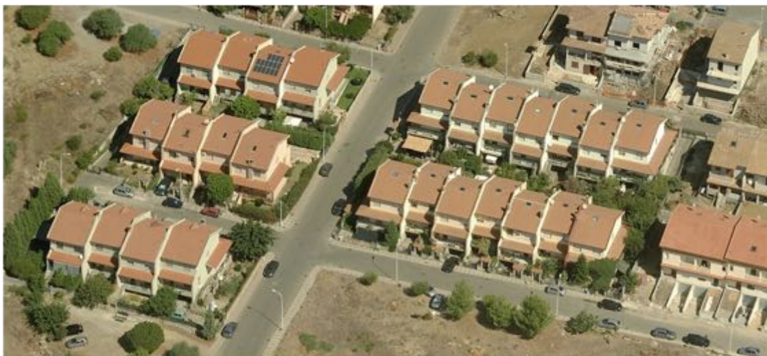
Vista 2-1, edifici in linea, zona C1.1 PdZ
