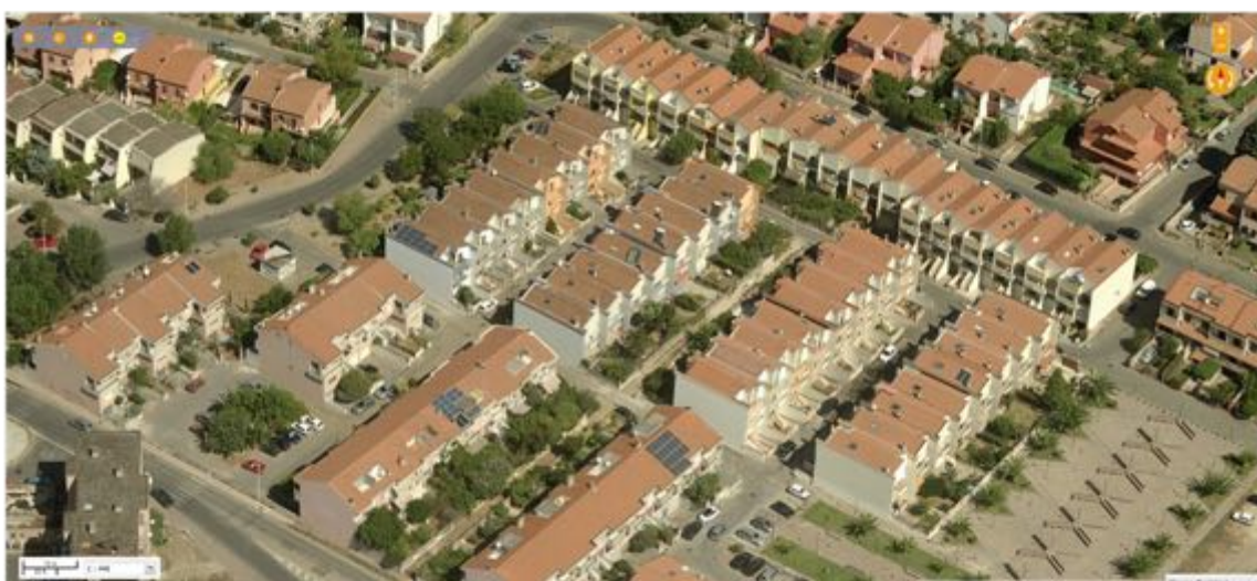
Vista 3-2, edifici in linea, zona C1.1 PdZ
