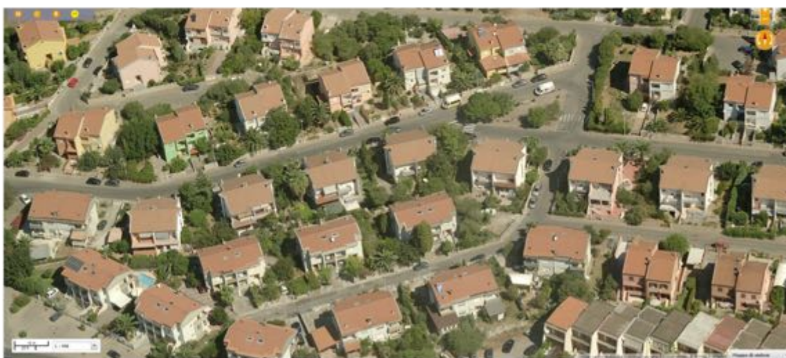
Vista 3-3, edifici isolati, zona C1.1 PdZ
