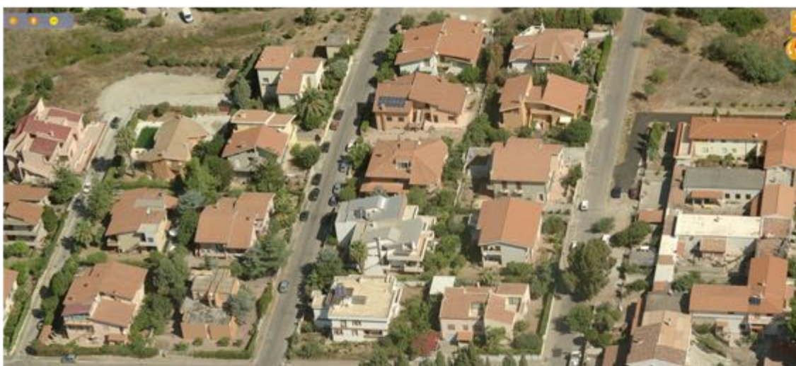
Vista 1-2, edifici isolati, zona B2.1
