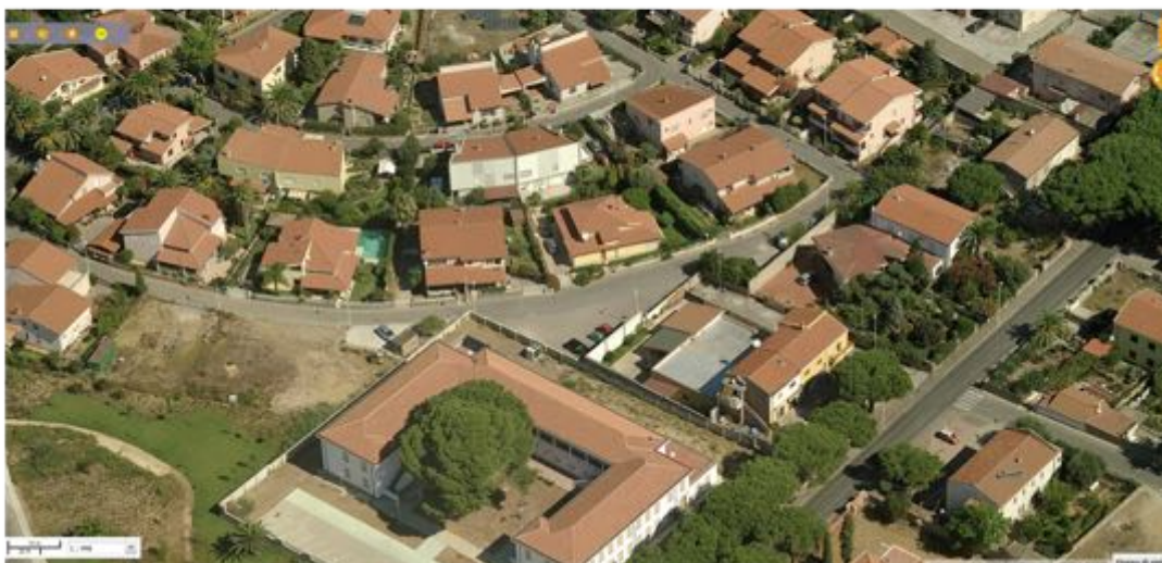
Vista 1-1, zona C1.1
