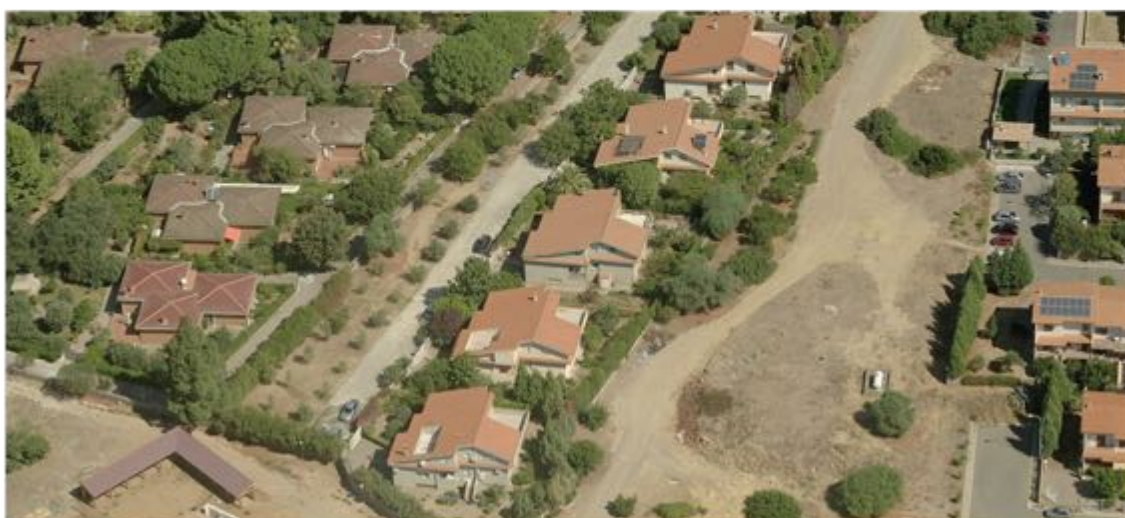
Vista 1-3, edifici isolati, zona B2.1
