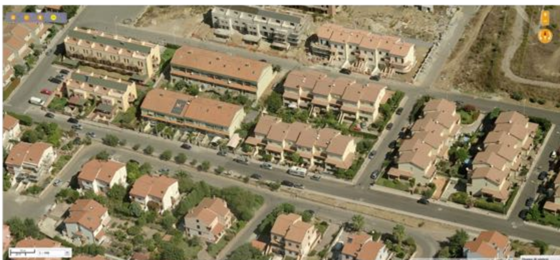
Vista 2-3, edifici in linea, zona C1.1 PdZ
