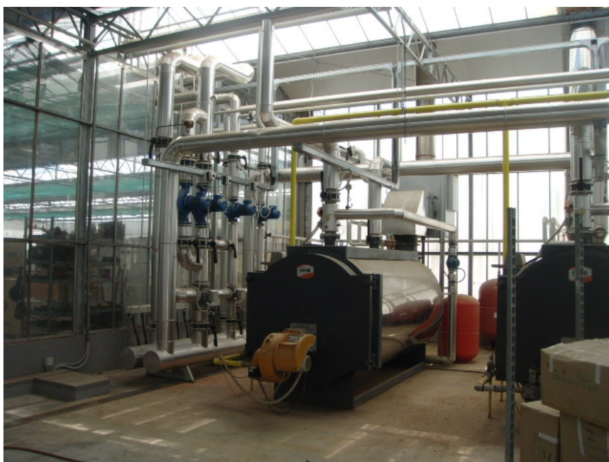
Figura 37. Caldaia in centrale termica a servizio di una serra.
