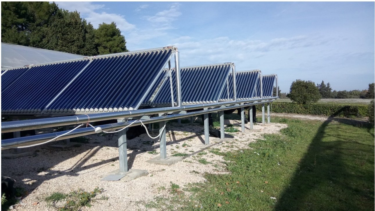
Figura 4. Il campo solare dell'impianto di solar cooling presso l'Università di Bari.
