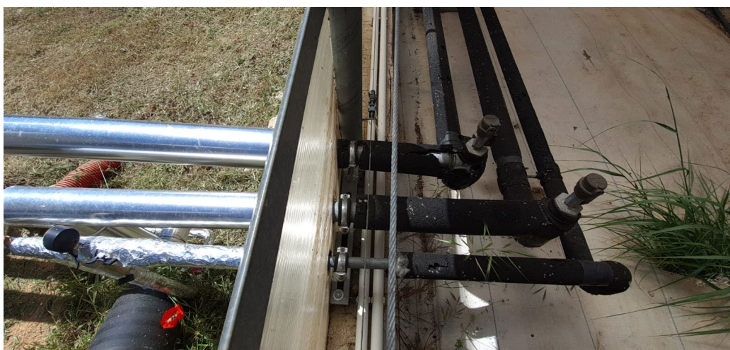
Figura 8: Tubazioni principali che trasportano all'interno della serra l'acqua fredda dal serbatoio freddo
