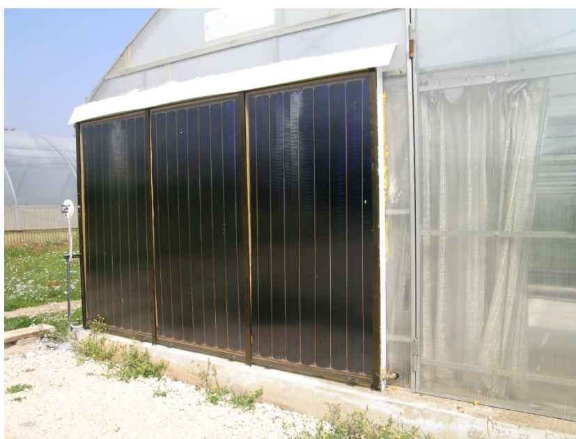
Figura 47. Collettori solari termici a servizio di una serra sperimentale collocati sulla testata a Sud.
