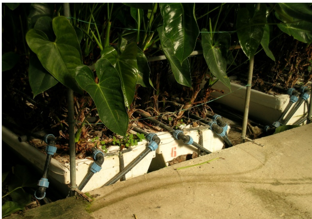
Figura 41. Sistema di riscaldamento a termosifone ad acqua calda con tubazioni in polietilene posizionate sul substrato di coltivazione.
