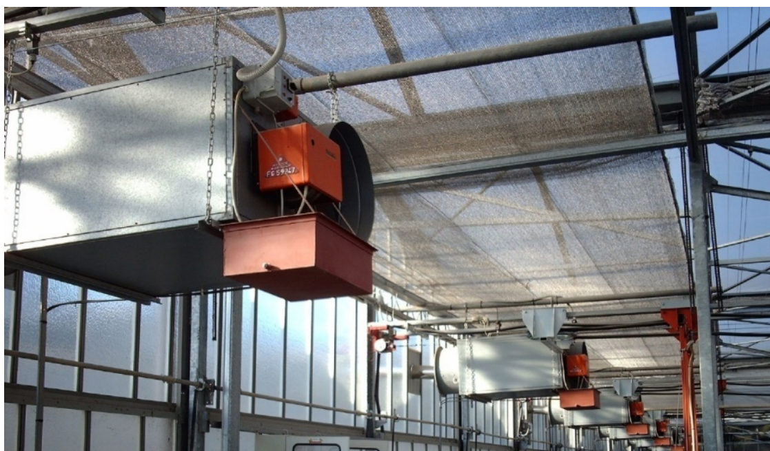
Figura 44. Generatori di aria calda di tipo fisso.
