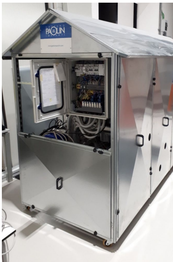
Figura 20. Sottostazione completamente assemblata
