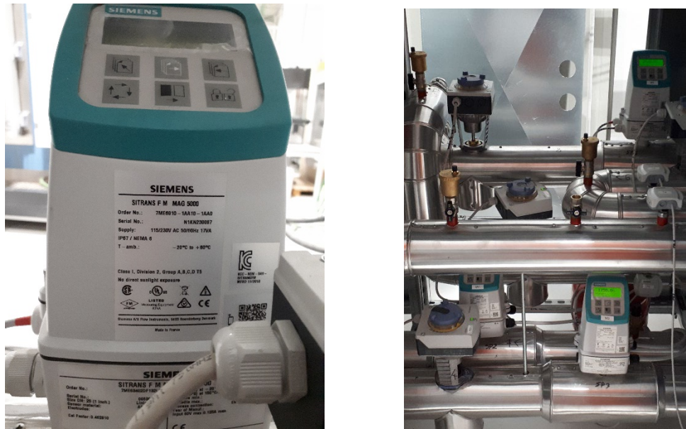
Figura 26. Flussimetro (a sinistra) e sua installazione nella sottostazione (a destra)
