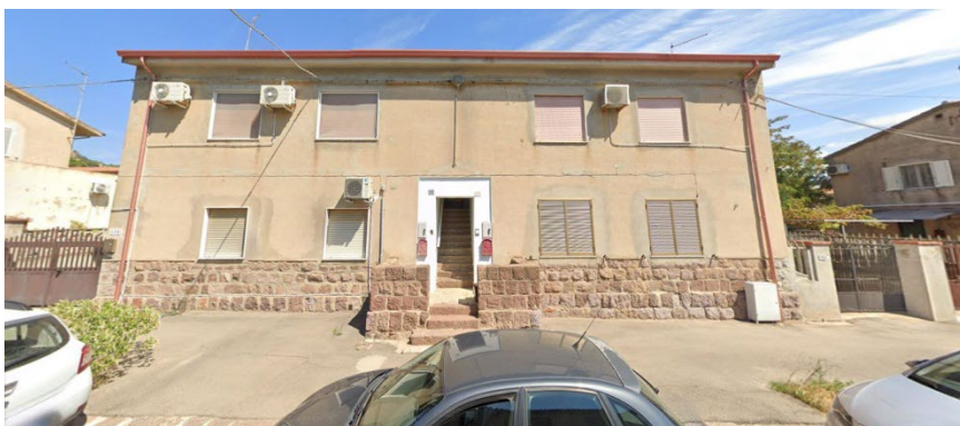
Figura 4: Edificio GRA-M allo stato attuale
