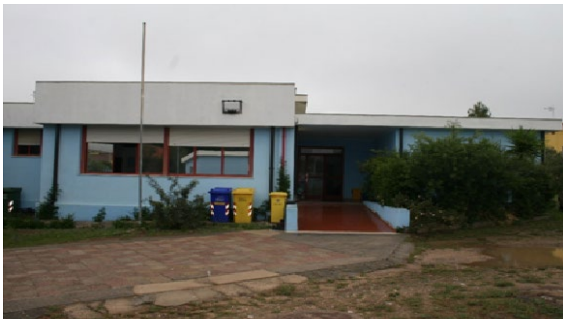
Figura 16: Scuola primaria Is Gannaus allo stato attuale
