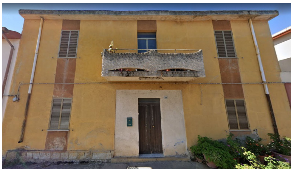
Figura 6: Esempio di edificio Generico-B1 allo stato attuale
