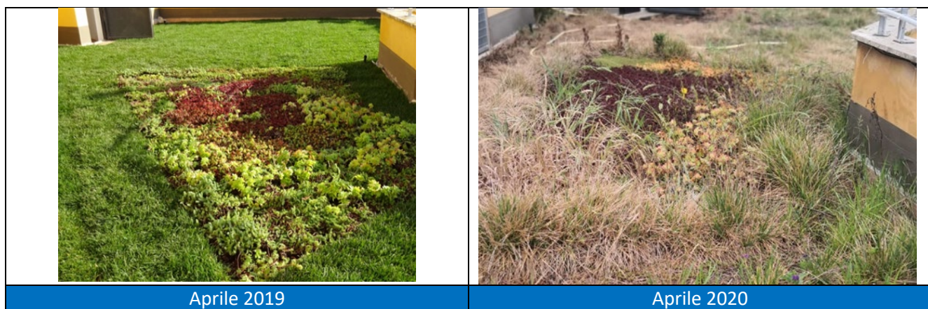
Figura 29. Confronto dello stato del tetto verde tra aprile 2019 e aprile 2020
