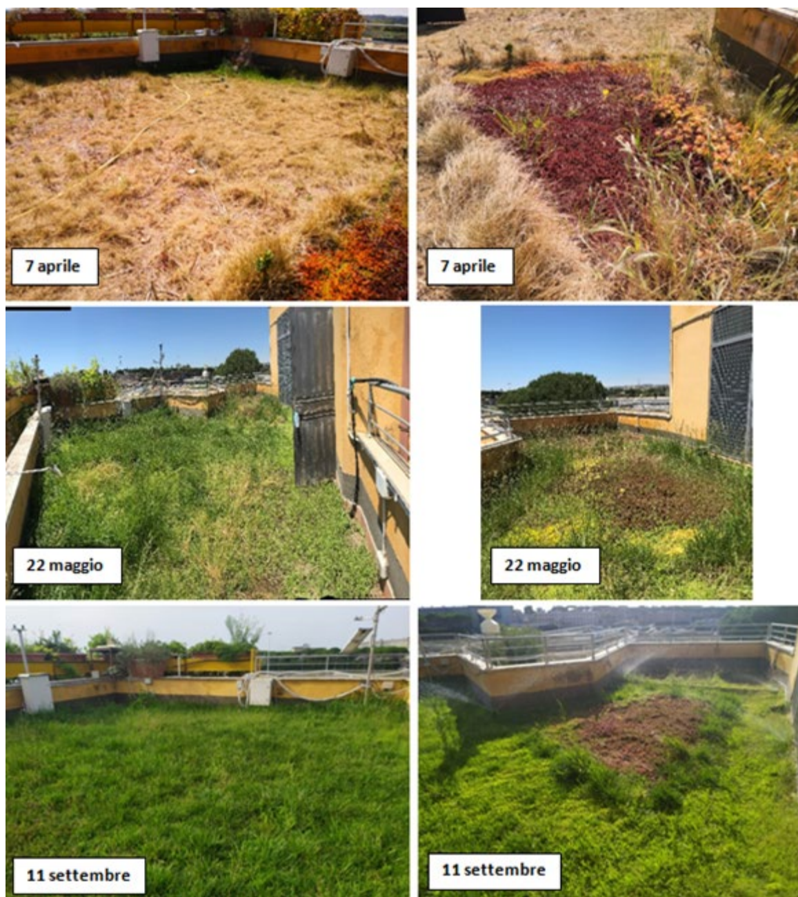
Figura 28 Tetto verde ENEA. Le fotografie a sinistra si riferiscono all'appezzamento a Graminaceae di Festuca arundinacea e Poa pratensis , mentre quelle a destra all'appezzamento a Sedum
