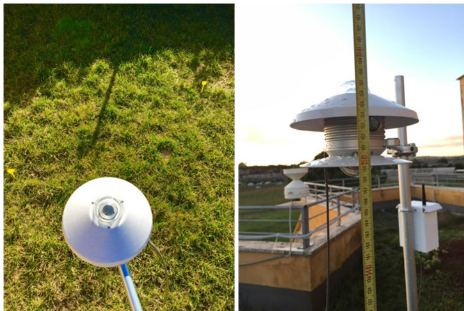
Figura 50. Area di misurazione e altezza strumento
