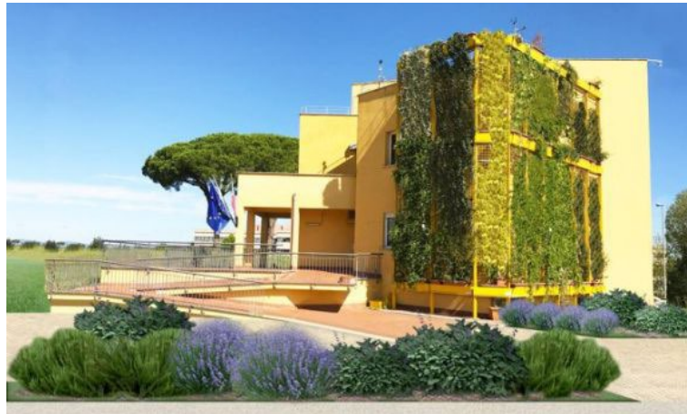
Figura 83. Edificio Prototipo sperimentale ENEA di pareti e tetto verde
