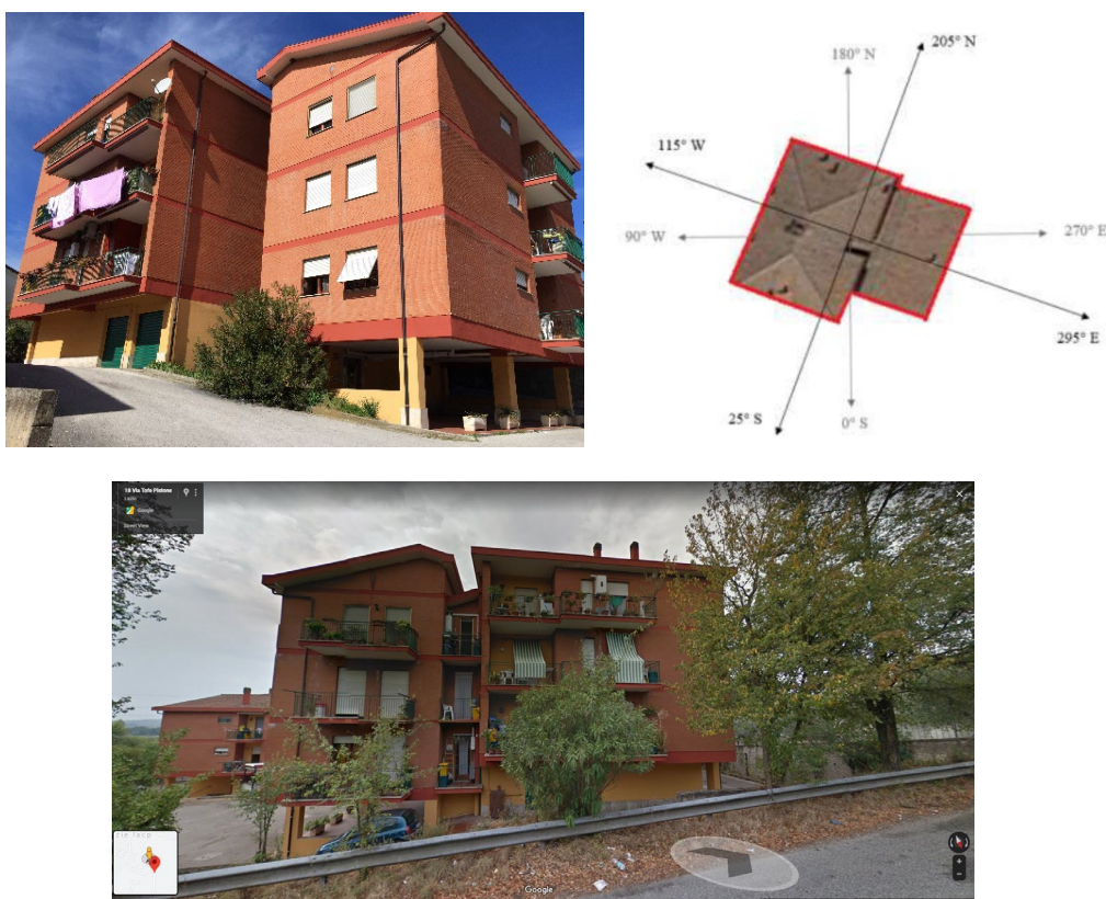
Figura 28 – Edificio caso di studio Anagni ATER 18C
