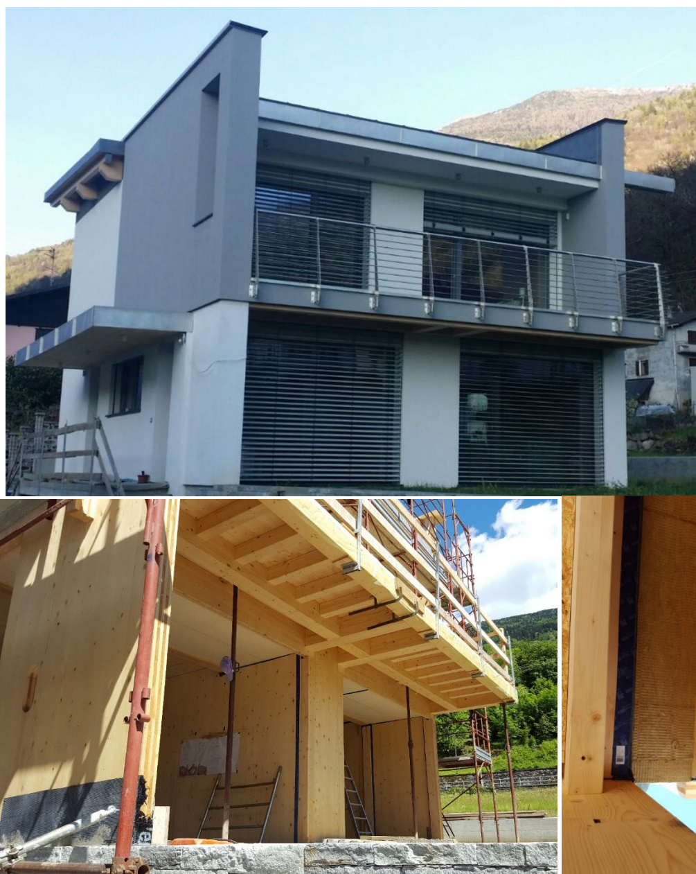
Figura 4-1 Caso studio 1: vista d'insieme e dettagli della fase di costruzione
