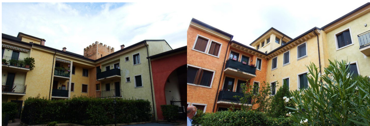
Figura 5-2 Sulla sinistra foto di una delle torri sulle quali sono situate le unità adibite al raffrescamento, sulla destra foto di una delle torri chiuse e contenenti la centrale termica.
