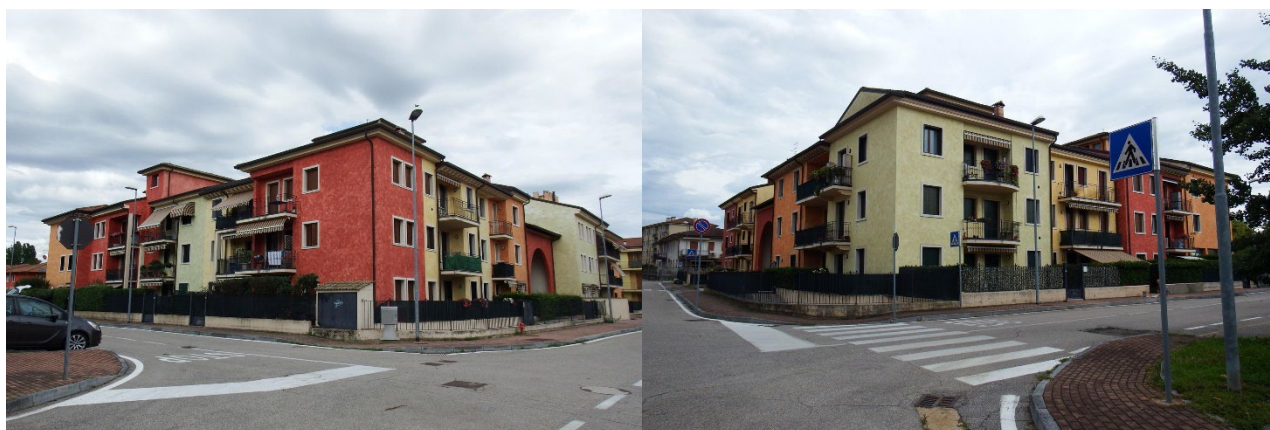
Figura 5-1 A sinistra foto del complesso Corte Veronica, a destra foto del complesso Corte Sara
