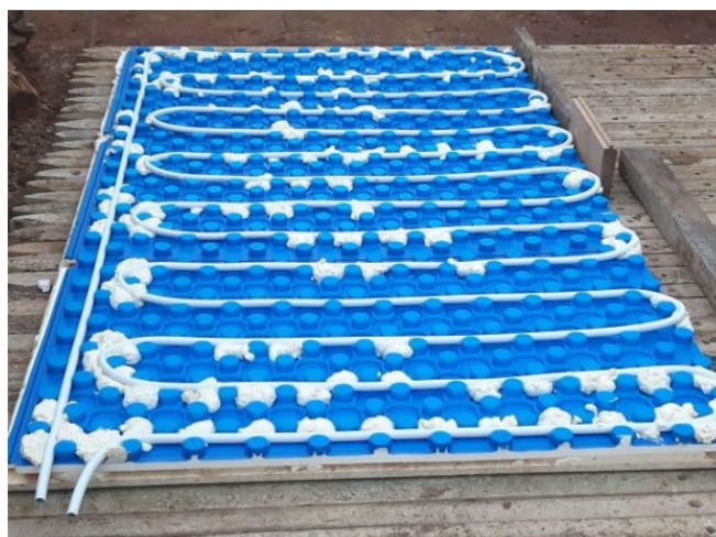
Figura 4-8: Piastra termica per fornire il calore di scarto al biodigestore per mantenere il digestato ad una temperatura maggiore di 30°C
