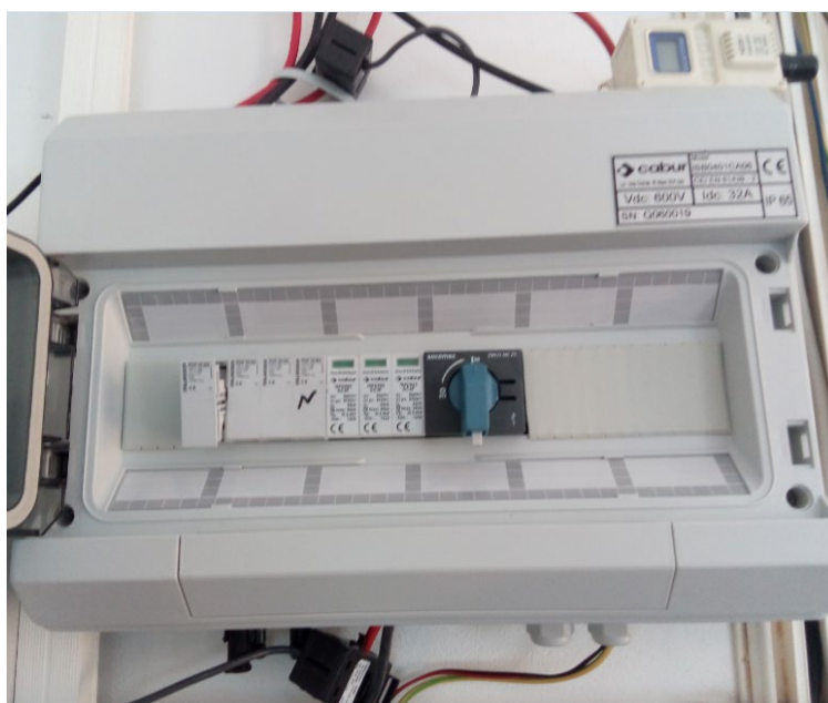
Figura 2-11: Quadro di campo per sezionamento e parallelo delle tre stringhe e TA per misura corrente totale da FV
