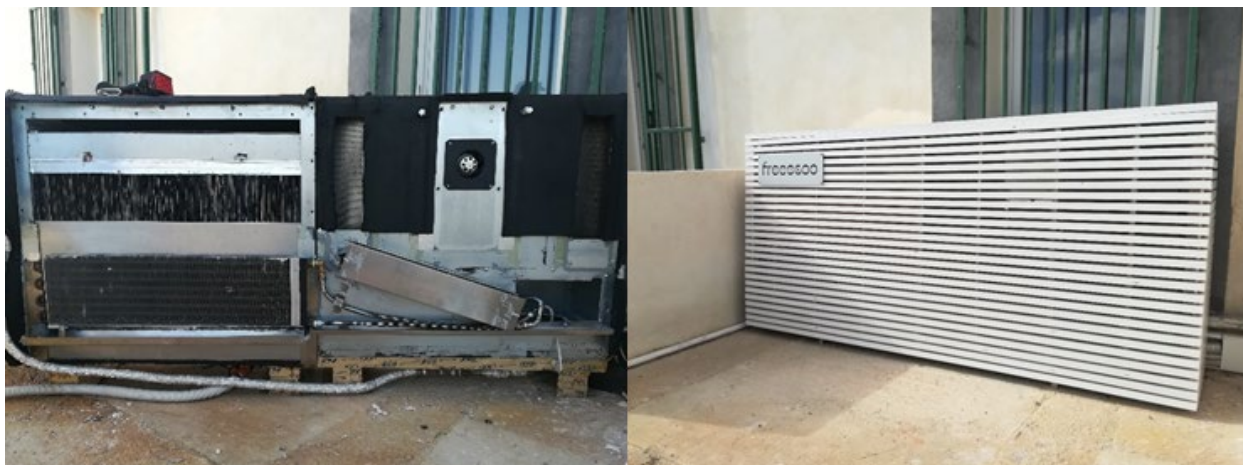
Figura 3-11: Sistema Freesco compacto installato a parete: a destra foto componenti interni della macchina, a sinistra posizionamento del sistema completo
