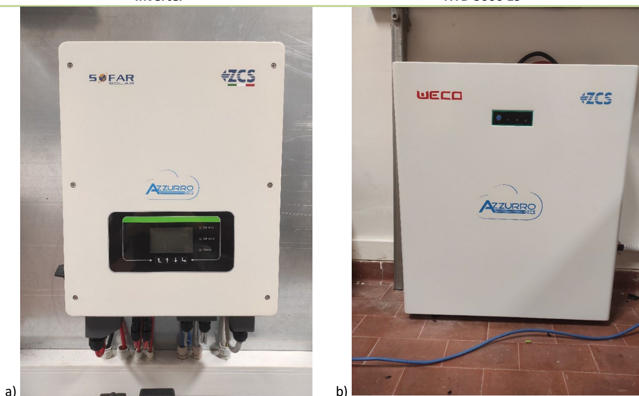
Figura 70. Inverter ibrido HYD 6000 ES di ZCS (a) e sistema di accumulo da 5kWh (b).
