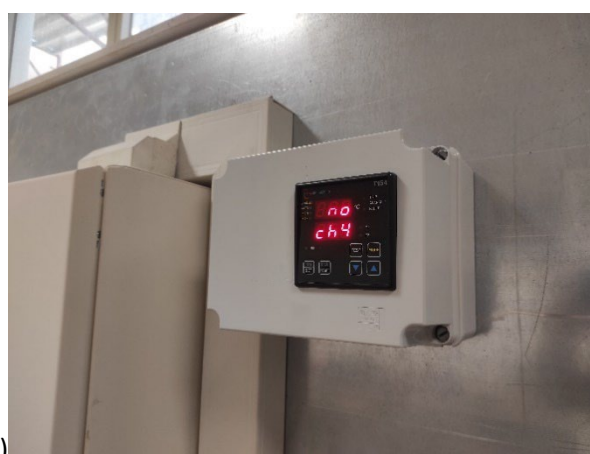
Figura 67. Trasformatore di isolamento (a) e centralina di controllo della temperatura (b).
