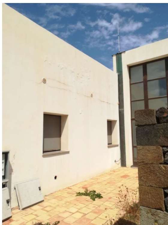
Figura 7. Parete SUD-EST della mediateca.
