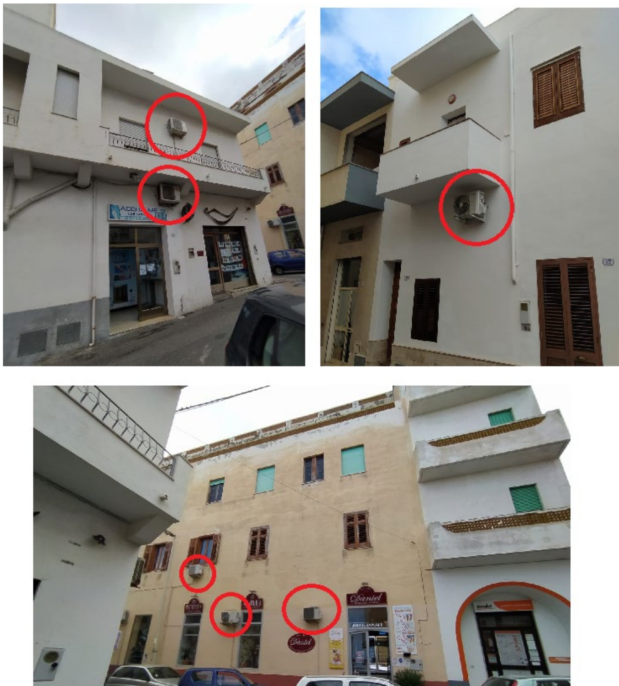
Figura 83. Alcuni esempi di unità esterne per impianti di condizionamento.
