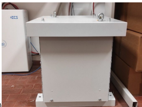
Figura 67. Trasformatore di isolamento (a) e centralina di controllo della temperatura (b).
