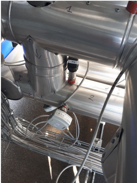
Figura 5.145. Posizione sensore di temperatura T2 prima (sinistra) e dopo (destra) lo spostamento
