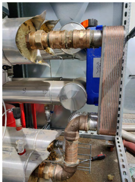
Figura 5.144. Scambiatore sovradimensionato (sinistra) e scambiatore sostitutivo (destra)
