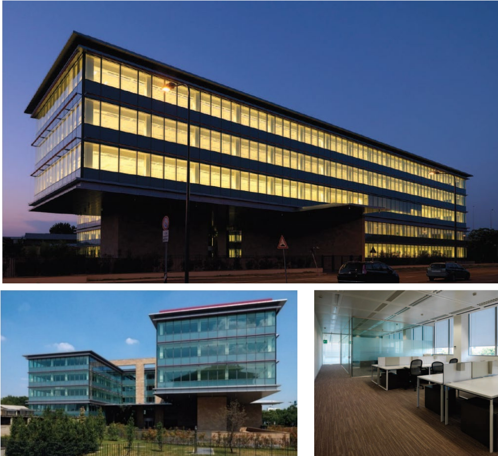
Figura 8. Viste delle facciate e di un interno del complesso direzionale Auros, tratte da [7].
