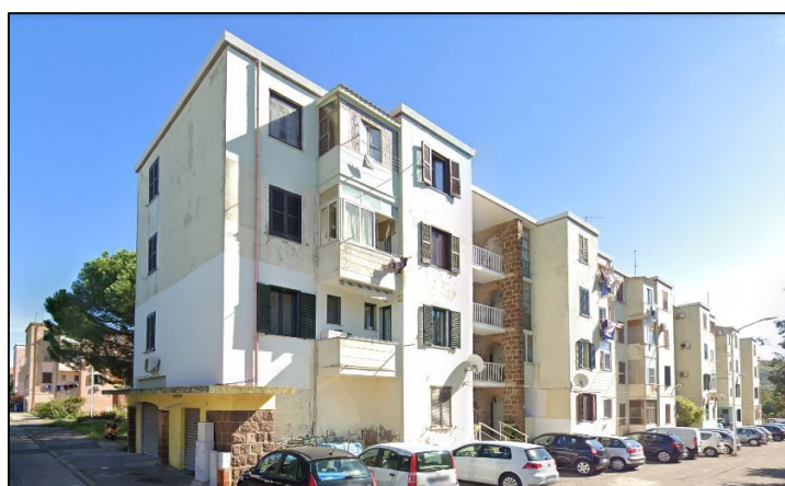
Figura 9 Edificio tipologia b1 allo stato attuale.
