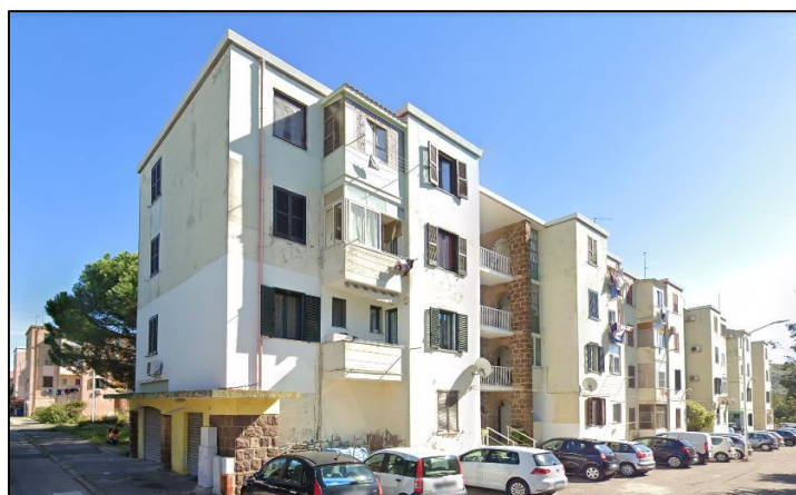
Figura 2 Edificio tipologia b1 allo stato attuale.
