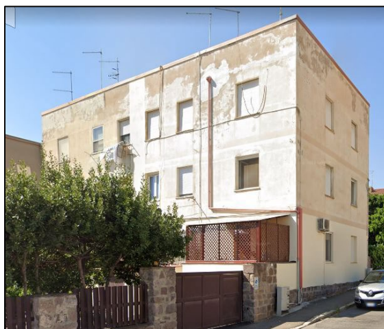
Figura 8 Edificio Spec E2 allo stato attuale.
