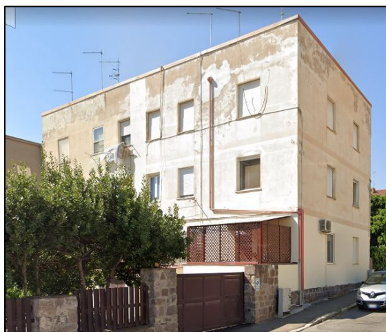
Figura 6 Edificio Spec E2 allo stato attuale.
