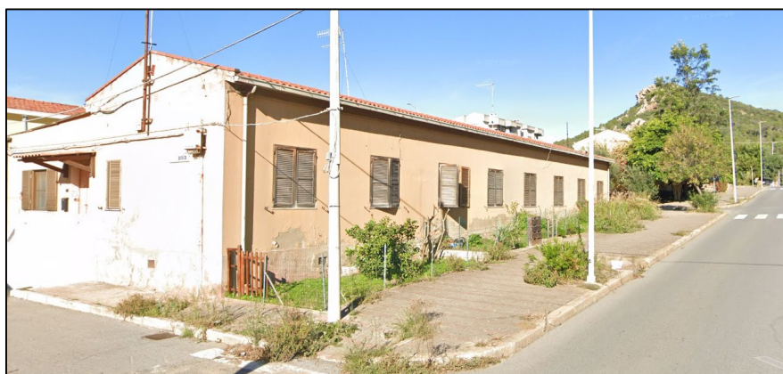
Figura 1 Edificio Gra B allo stato attuale.
