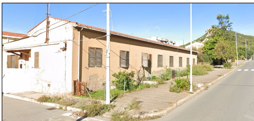
Figura 1 Edificio Gra B allo stato attuale.
